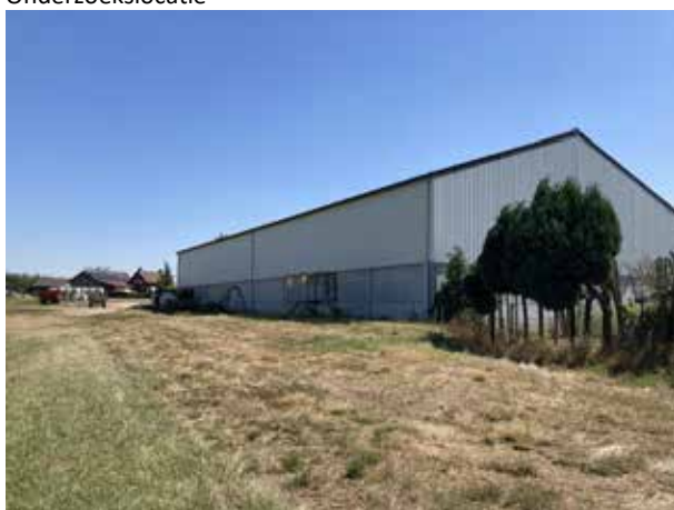
Foto 3 Aanzicht vanuit de onderzoekslocatie naar de naastgelegen loos
