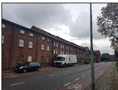
Figuur 6. Zuidzijde voormalige dakpannenfabriek "De Valk".
