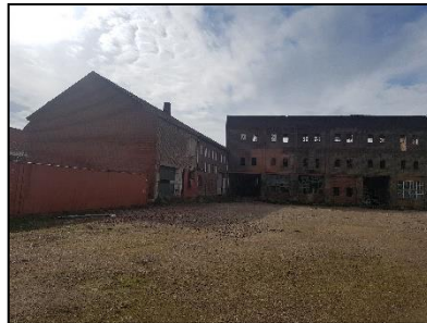
Figuur 4. Noordzijde voormalige dakpannenfabriek "De Valk".
