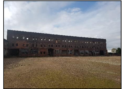
Figuur 5. Noordzijde voormalige dakpannenfabriek "De Valk".
