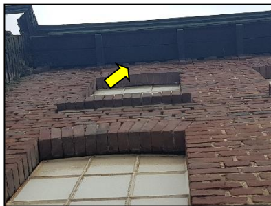
Figuur 10. Ruimte tussen muur en overstek.
