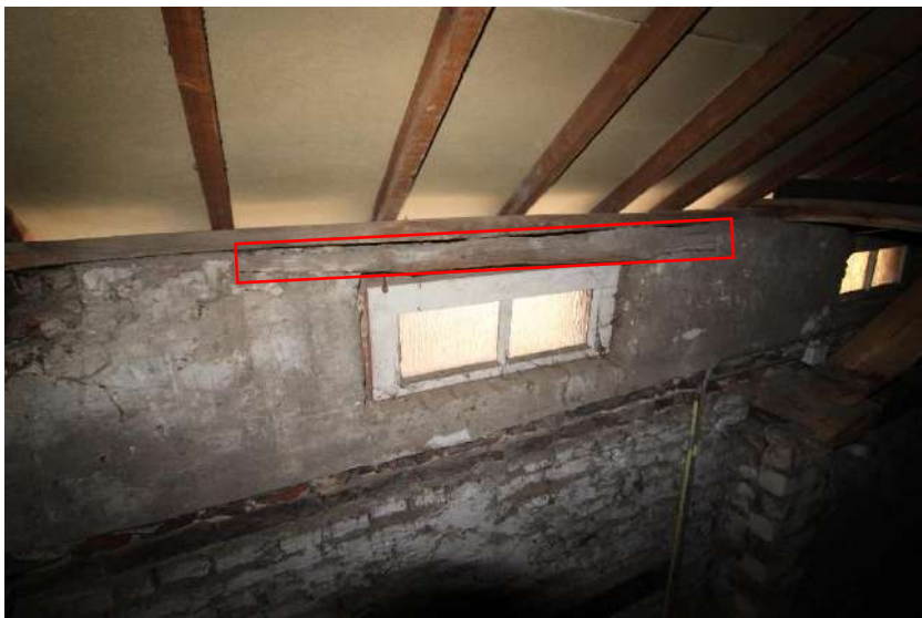
Houten latei boven beluchtingsvenster
