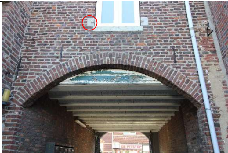
De achtergevel toont nog de hardstenen neuten (rode cirkel) waar oorspronkelijk de luiken in bevestigd zaten.
