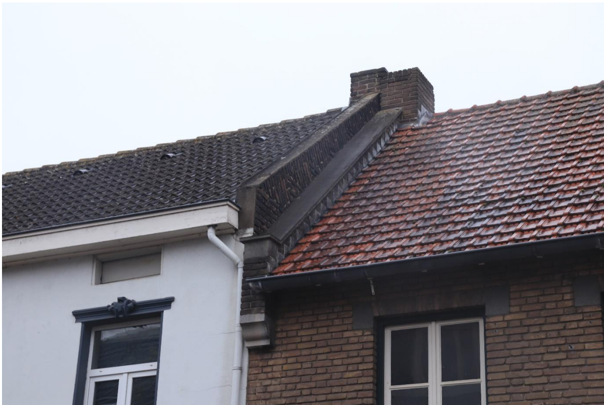
Foto 1: Beeld vanaf de Bovenste straat op te slopen bebouwing
