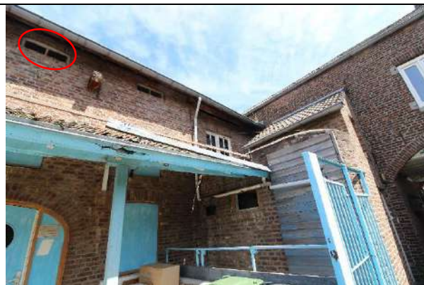
Ontluchtingsgaten (rode cirkel) in het voormalige brouwerij gedeelte, hier bevond zich de eestzolder. Onderstaand de muur op het binnenterrein die oorspronkelijk hoorde bij een inmiddels verdwenen bouwvolume.
