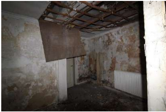
Deur naar de kelder
