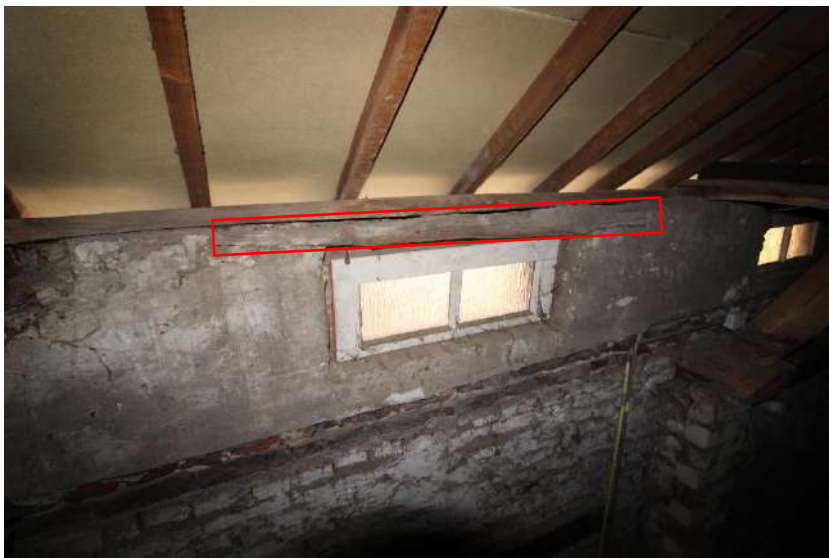
Houten latei boven beluchtingsvenster
