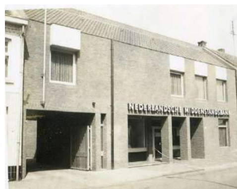
Afb. 59 Voorgevel aanzicht ongedateerd
