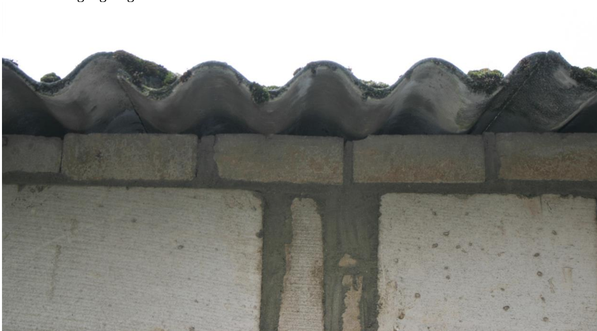
Figuur 4.2.2. Onder de ‘golven’ van stal 2 ontbreekt vogelschroot.
