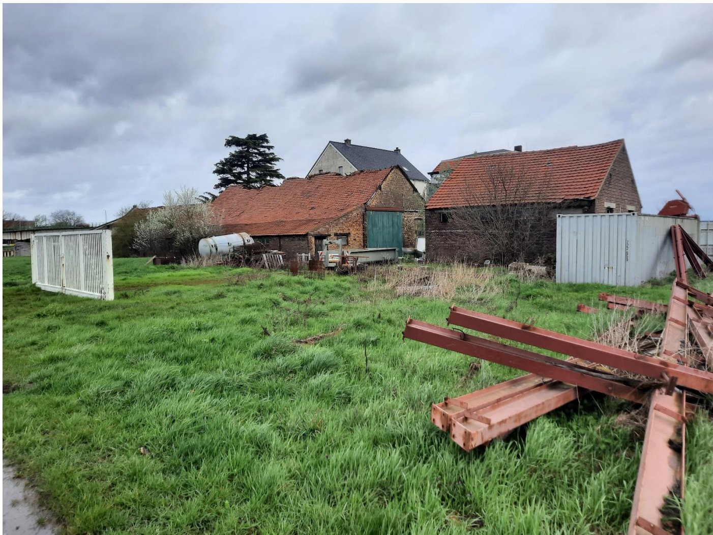
Figuur 40 Twee vervallen schuren achter Schansberg 5 en 7 (foto gemaakt in noordelijke richting).
