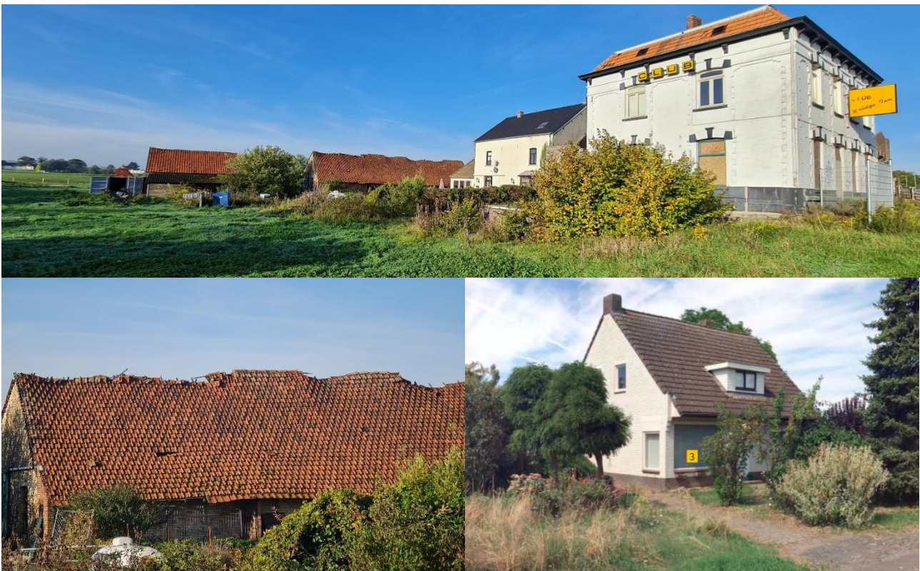
Figuur 3. Impressie van de bebouwing in het plangebied.
