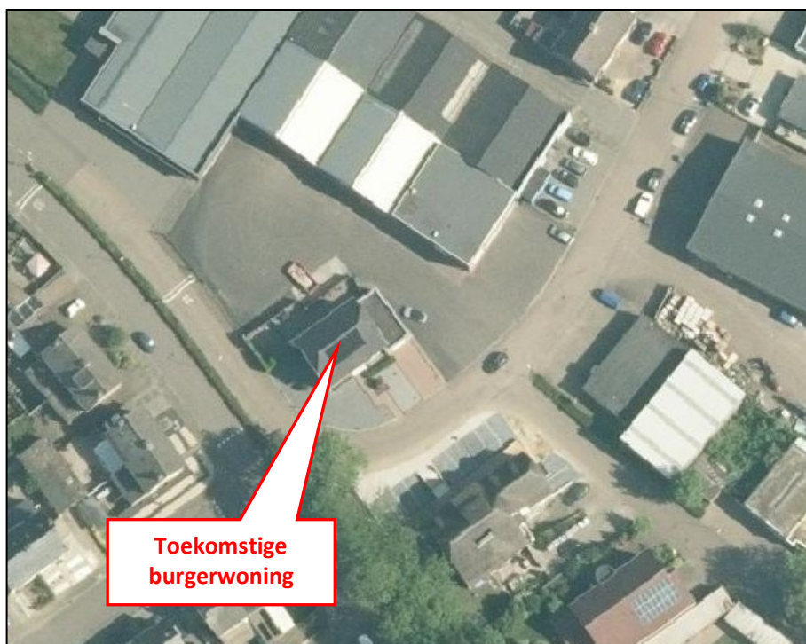
Figuur 1. Luchtfoto met ligging bedrijfslocatie
