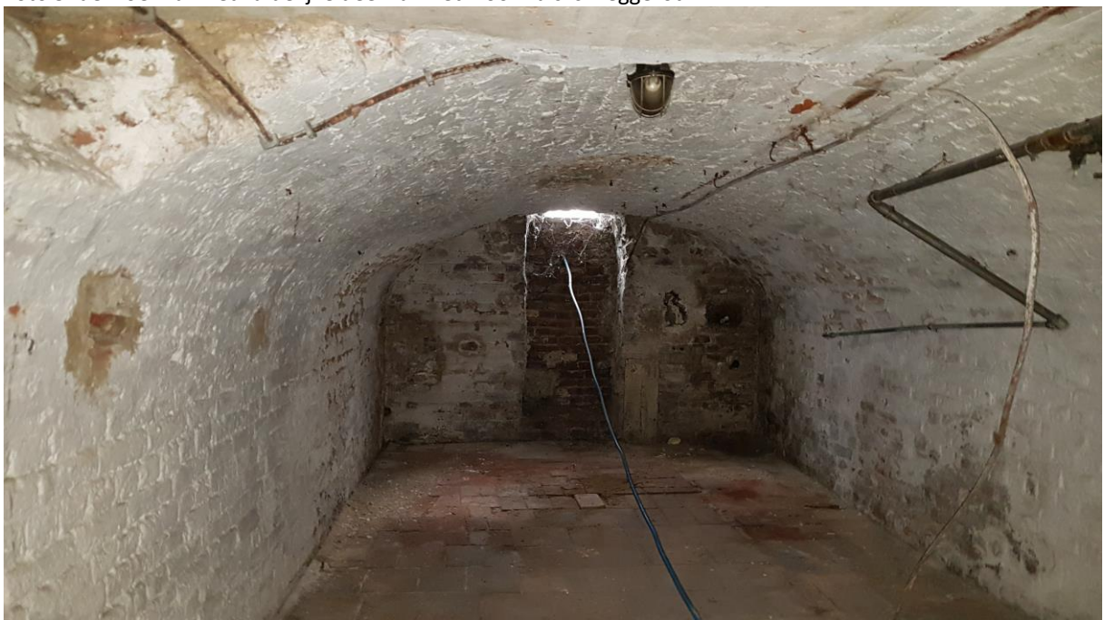
Foto 6: de kelder onder het woonhuis.
