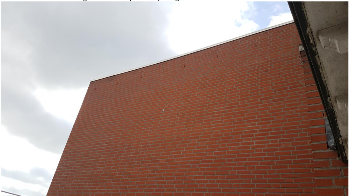
foto 19: het zuidelijke buurpand heeft open stootvoegen in de gevel die het nieuwe pand kan blokkeren.
