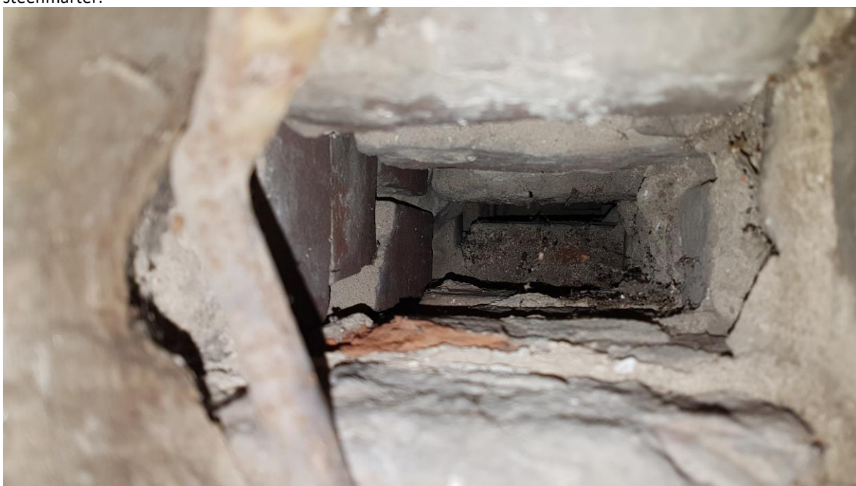
Foto 17: vanaf de zolder is te zien dat de muren een spouw hebben.
