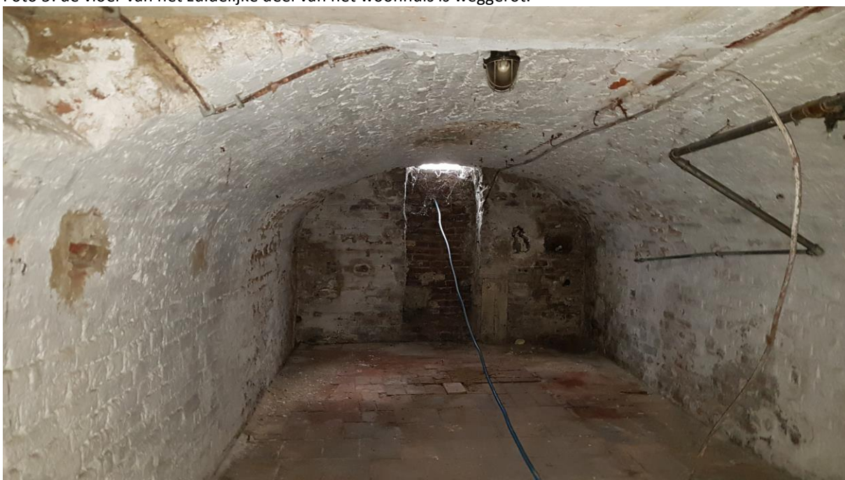
Foto 6: de kelder onder het woonhuis.
