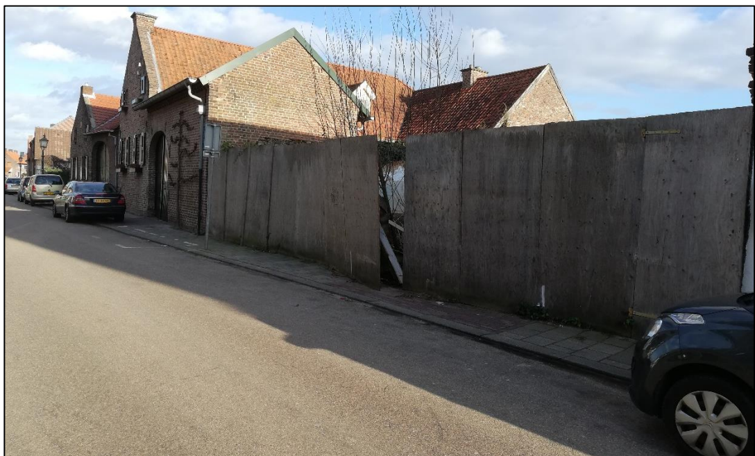
Aanzicht deelgebied 1, gezien vanaf de westzijde (Haverterstraat)
