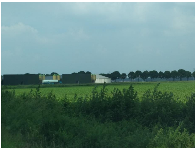
Foto 4: zicht op projectlocatie vanaf westzijde (Groeneweg)
