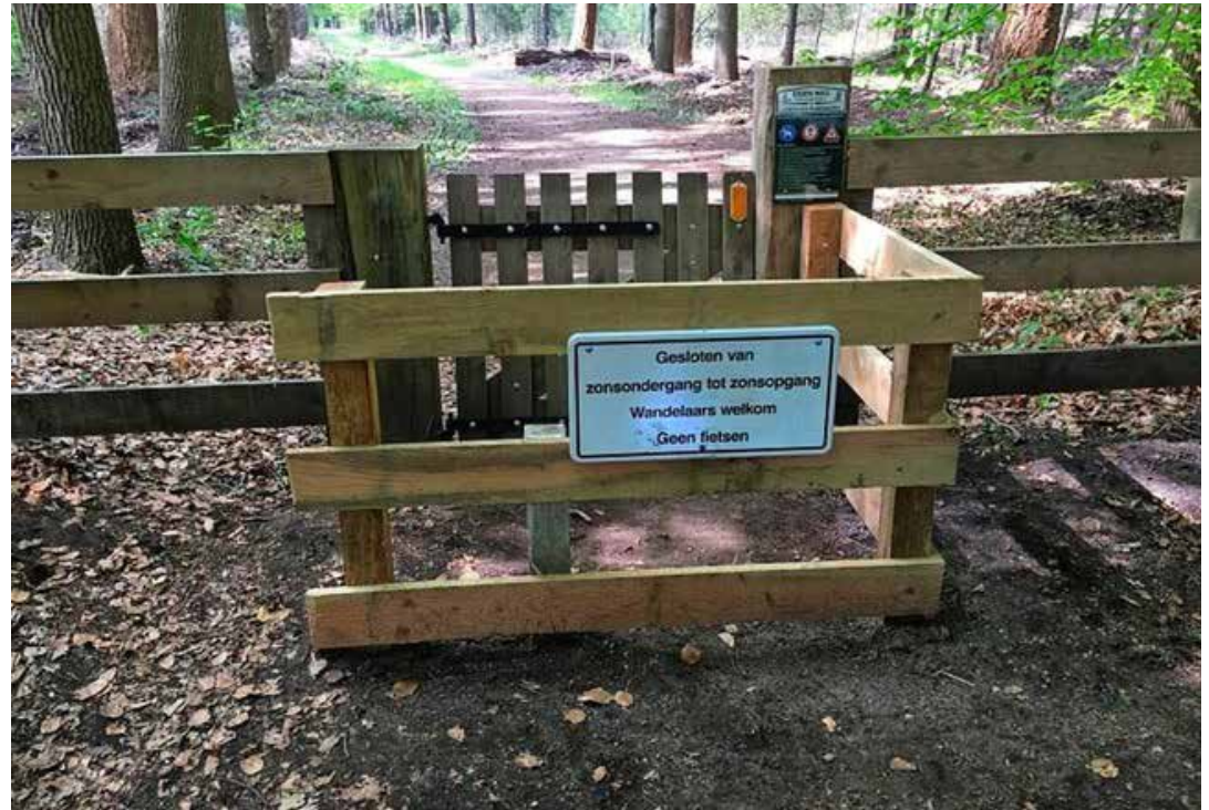
Referentie klaphek met fietsbarriere en bordjes toegankelijkheid.
