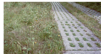
voorbeeld van karrenspoor als rijbaan (foto boven) materialisatie karrenspoor van 4 meter breed (foto onder)
