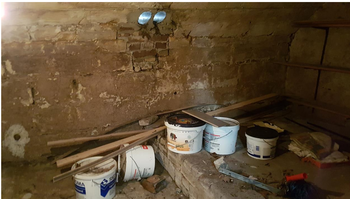
Foto 11: een van de twee kelders onder het hotel met de twee ventilatie kanalen . Hierbinnen zijn geen sporen aangetroffen.
