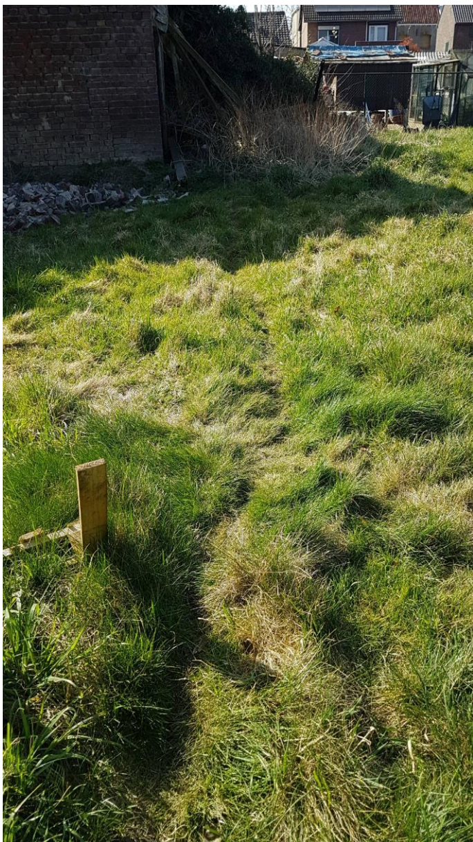
Foto 41: wissel tussen te ingestorte hooizolder met daarachter kippen hok en voilere, en de feestzaal.
