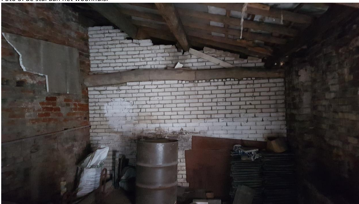
Foto 6: een van de garages naast het woonhuis.
