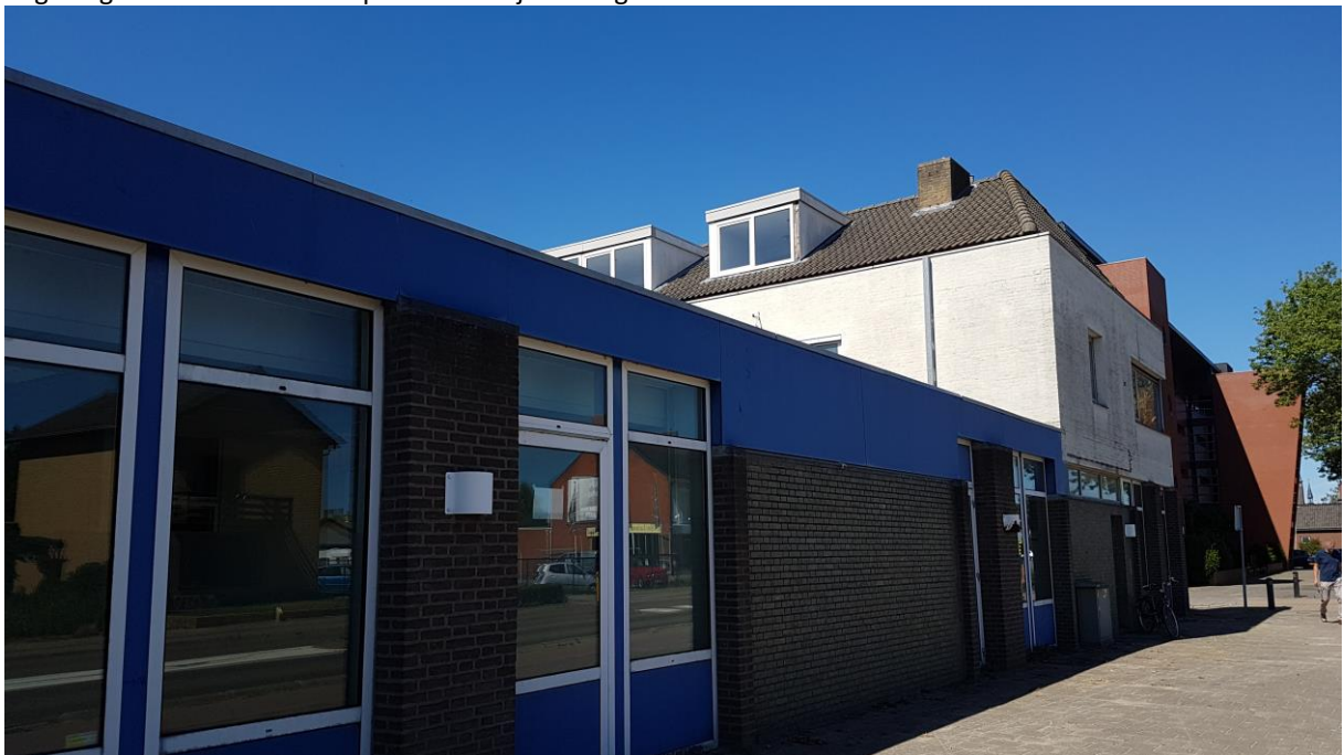
Foto 2: de noordelijke gevel van de onderzoekslocatie. De kijkrichting is naar het westen. Onder aan het boeiboord is een opening met de gevel. Echter zit hier een plastic strip onder waardoor vleermuizen er niet in kunnen.
