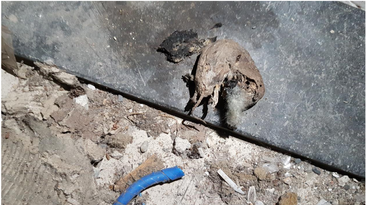
Foto 5: kadaver van een jonge marterachtigen. Aangetroffen in de kelder van Chatelainplein 1.
