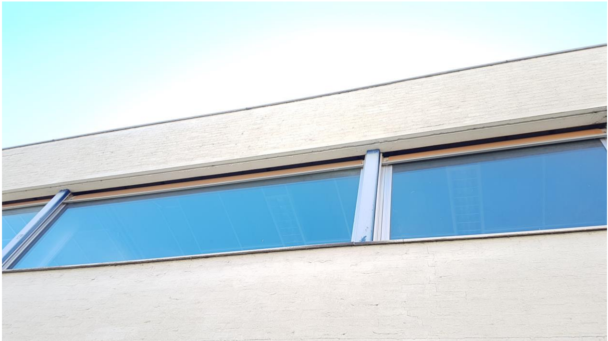
Foto 36: de ruimte boven de zonnewering van het kantoorpand biedt mogelijk verblijfplaatsen voor vleermuizen.
