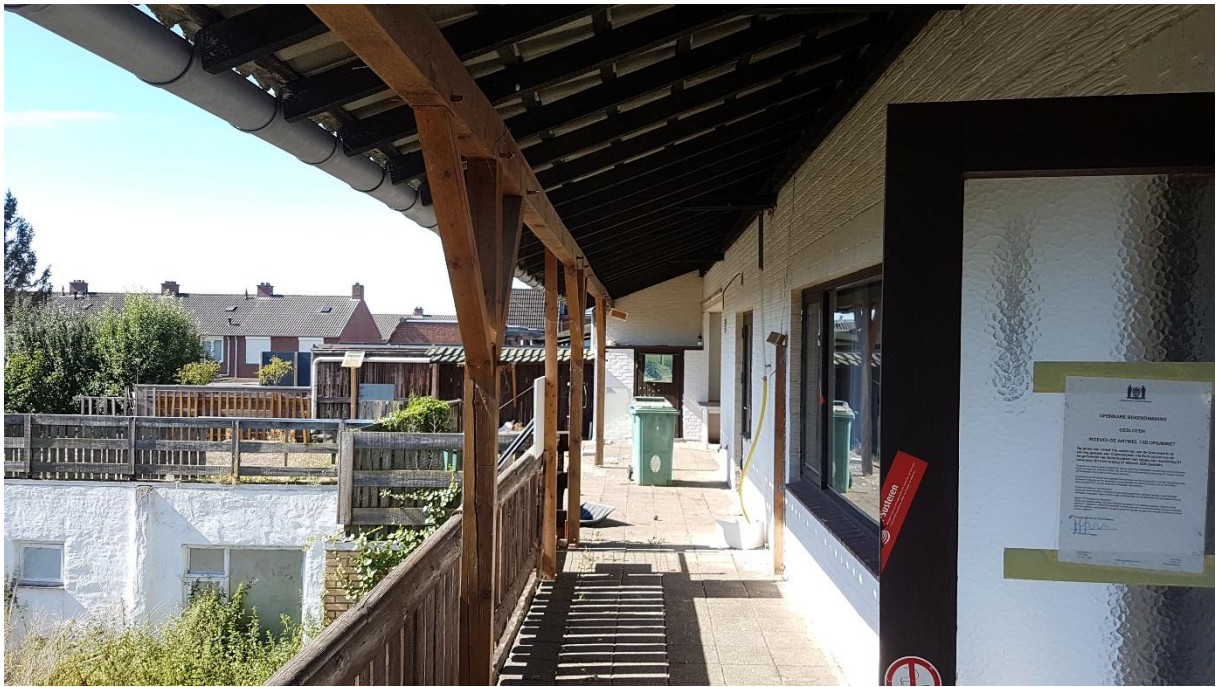
Foto 20: de overloop op de eerste verdieping die Chatelainplein 2 en 5 verbinden met in de achtergrond links het dakterras.
