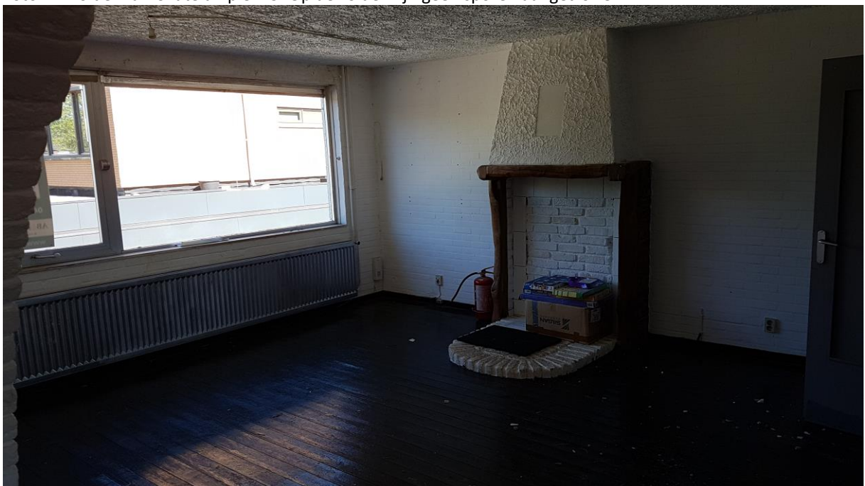
Foto 25: de 1 ste verdieping van Chatelainplein 5. Bij de ramen en kozijnen zijn geen sporen van vleermuizen aangetroffen.
