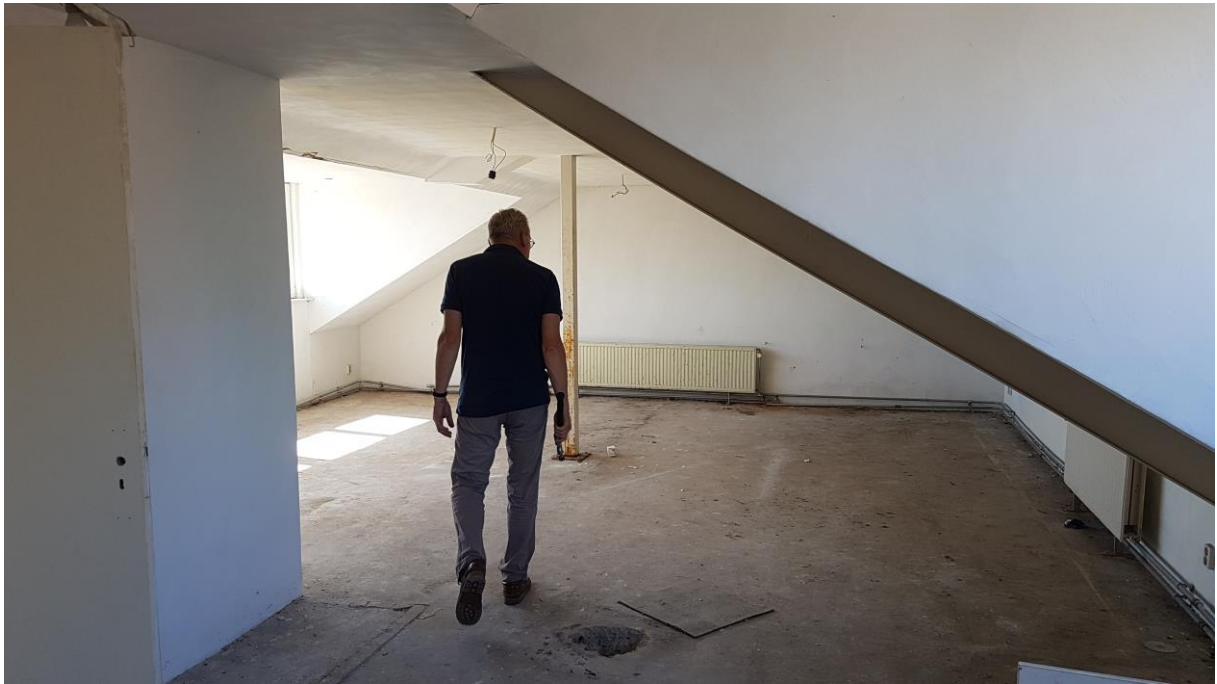
Foto 11: de bovenste verdieping van Chatelainplein 1 is eveneens leeg. Hier zijn twee skeletten van vogels aangetroffen. Een was volledig en compleet bij de andere miste stukken.
