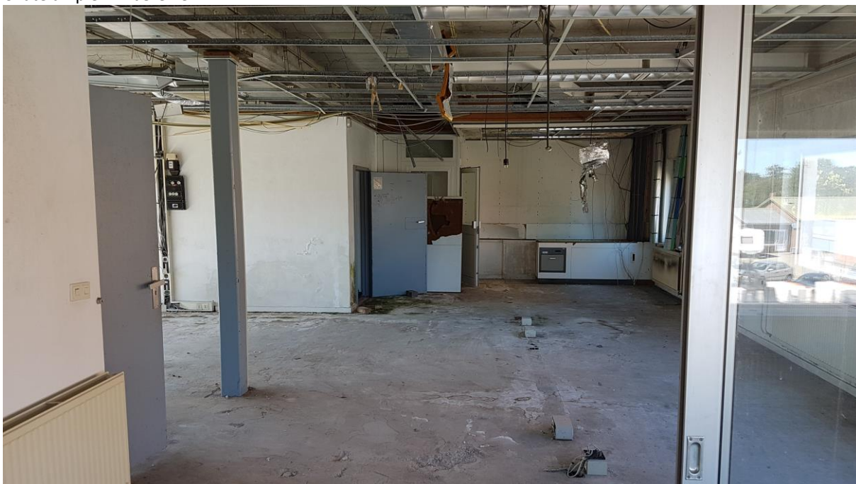
Foto 10: de eerste verdieping van Chatelainplein 1 is compleet leeg gehaald.
