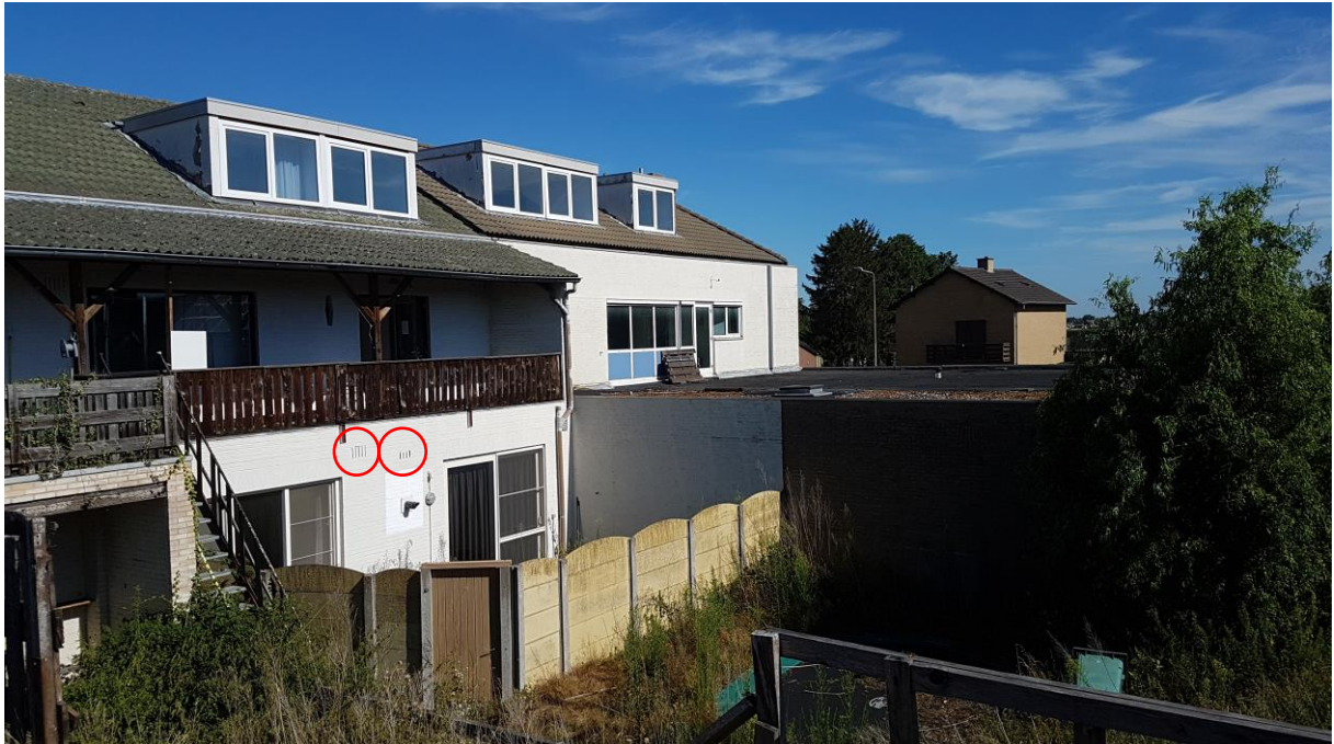
Foto 37: door dat het dak eerst in de goot loopt en de goot hoger is dan de dakrand is het niet geschikt voor de gierwaluw. Op de gevel van Chatelainplein 3a zitten ook openstootvoegen. Deze zijn echter breder dan die aan de westelijke gevel maar door de hoogte en de nabij staande schutting biedt het voor vleermuizen geen vrije uitvlieg opening. Een vleermuis valt eerst een stuk bij het uitvliegen voordat het verder kan vliegen.
