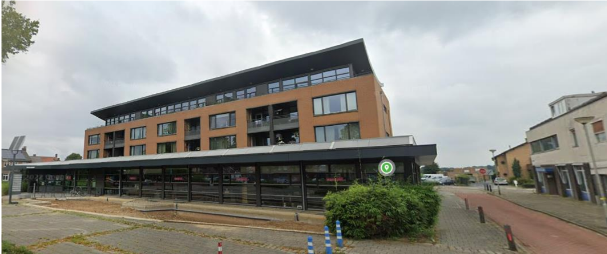
Bebouwing noordzijde Chatelainplein met rechts het voormalige pand van de Rabobank
