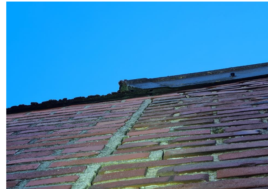
Figuur 5: Kieren langs dakrand van de westgevel
