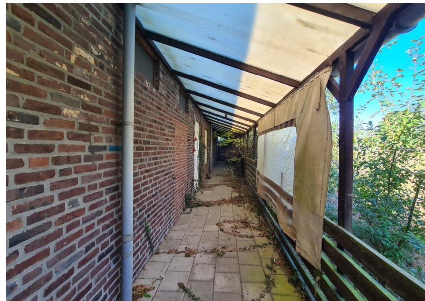
Figuur 6: Overkapping aan de achterzijde van het gebouw
