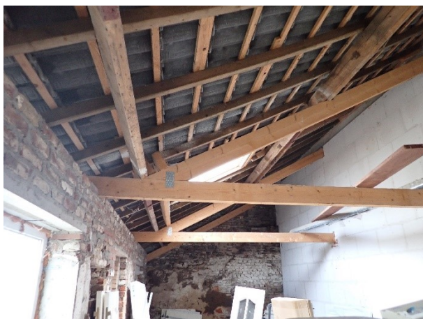
Foto 9: links, aanbouw zonder dakbeschot.
