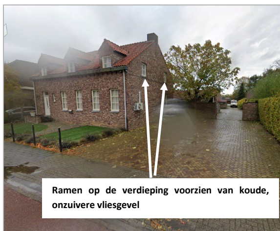
Figuur 10 Molenveldweg 6: ramen op de verdieping voorzien van koude, onzuivere vliesgevel
