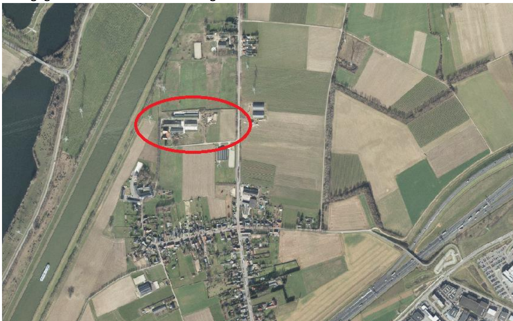
Afbeelding: Luchtfoto met locatie Swaantjesweg 16 te Echt (omcirkeld). De inmiddels gesloopte varkensstallen zijn hierop nog zichtbaar (bron: Gemeente Echt-Susteren).
