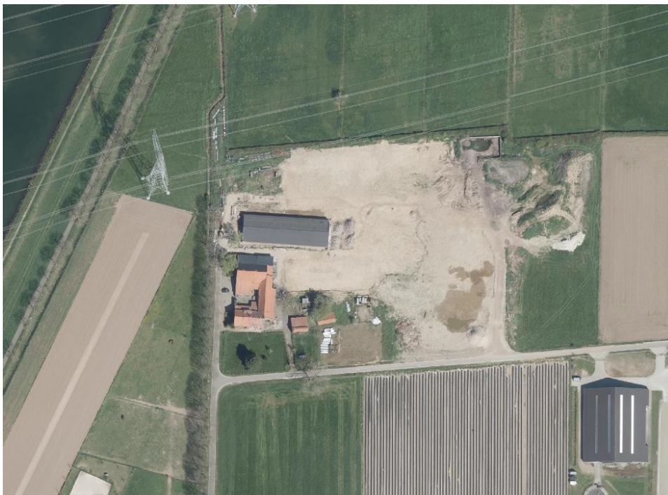
Afbeelding: Luchtfoto bedrijfslocatie Swaantjesweg 16 waarop te zien is dat de varkensstallen zijn gesloopt (PDOK luchtfoto Slagboom en Peeters d.d. 2022))
