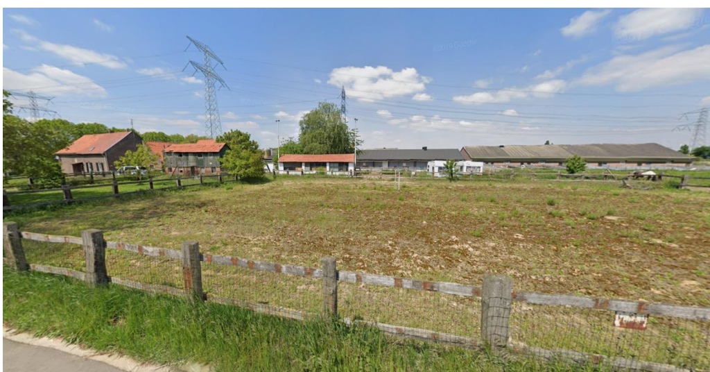
Afbeelding: locatie Swaantjesweg 16 te Echt gezien vanuit de zuidzijde van de bedrijfslocatie. De inmiddels gesloopte varkensstallen zijn hierop nog zichtbaar (bron: Google Streetview).
