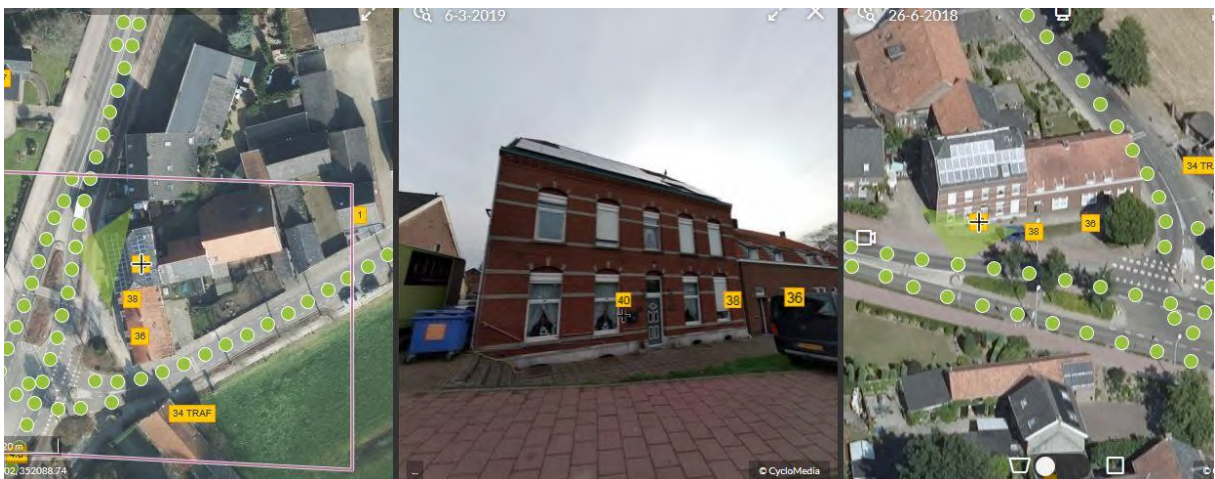
Heinsbergerweg 40 Melick, hoofdbouw te zeer aangetast met oa kunststof kozijnen, schuur weinig zichtbaar
