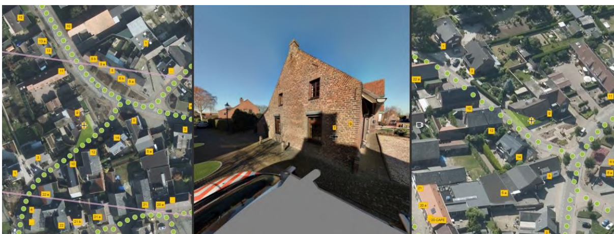
Bergerweg 7 Vlodrop, verandering kozijnen, rolluiken, geen originele dakpannen.
