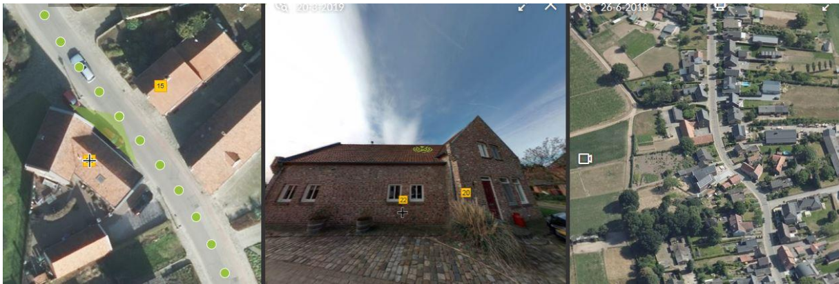
Waterschei 22 Melick, vervangende nieuwbouw
