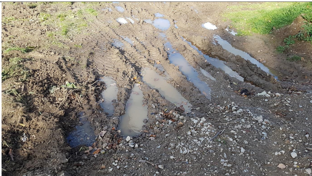
Foto 13: poelen ontstaan door de werkzaamheden.
