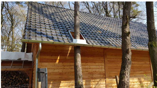
Figuur 8: Bijgebouw met uitsparing in het dak voor de aanwezige boom
