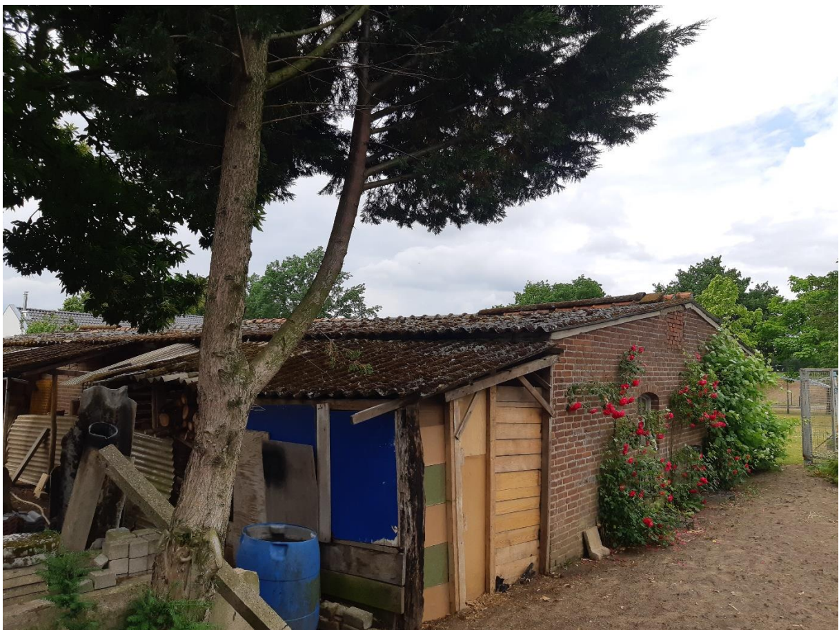
Foto 1: beeld van de te slopen loods aan de oostzijde (achterzijde)
