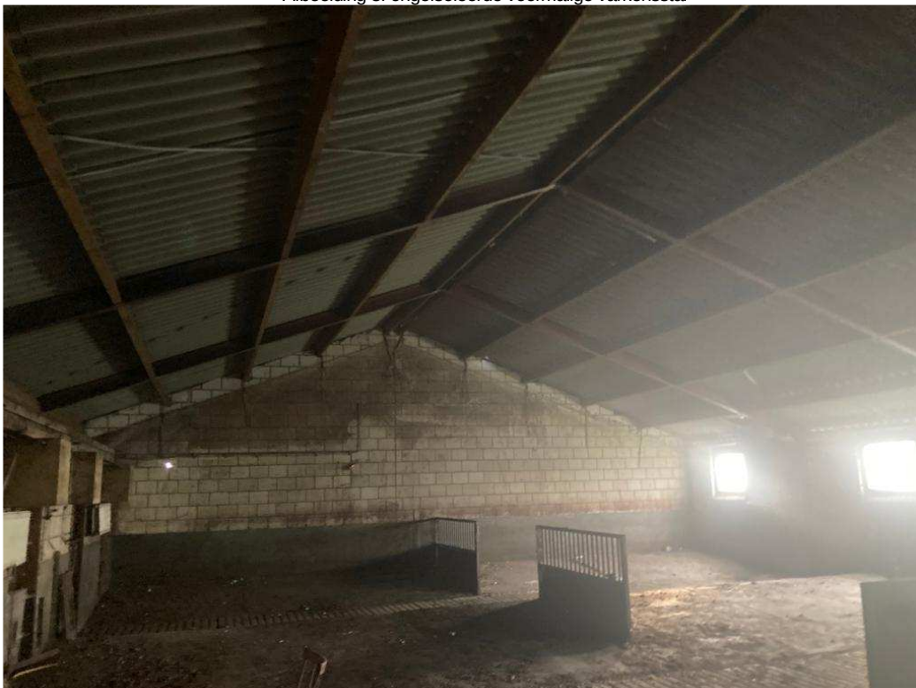
• Afbeelding 8: ongeïsoleerde voormalige varkensstal
