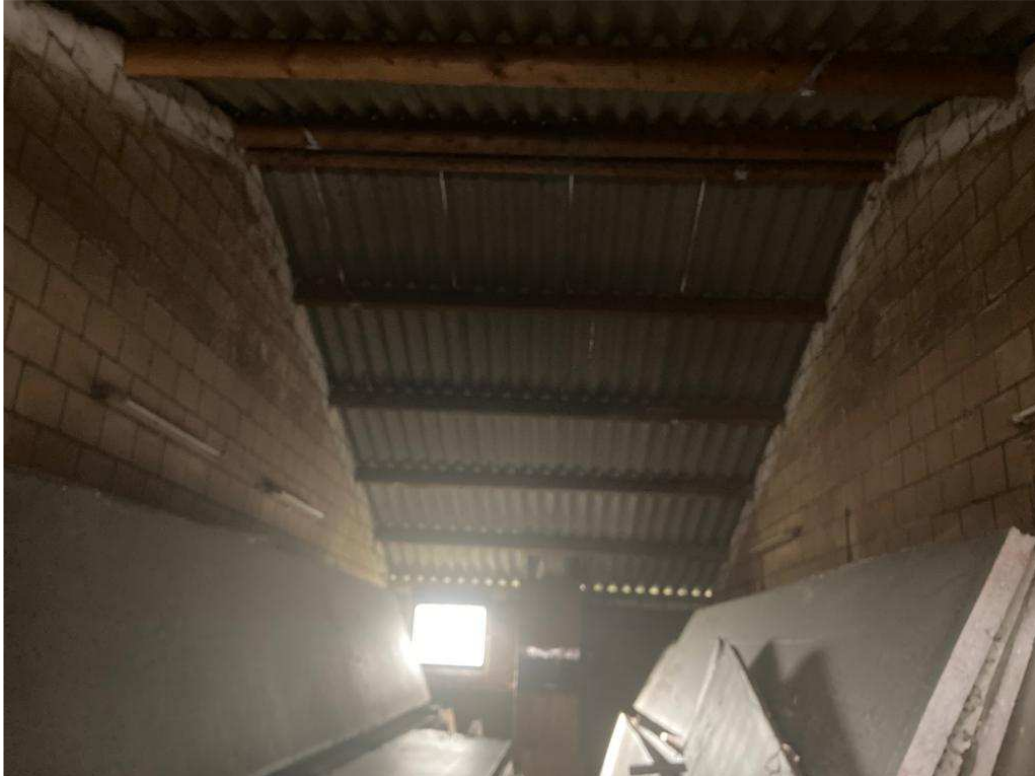
• Afbeelding 7: ongeïsoleerde voormalige varkensstal
