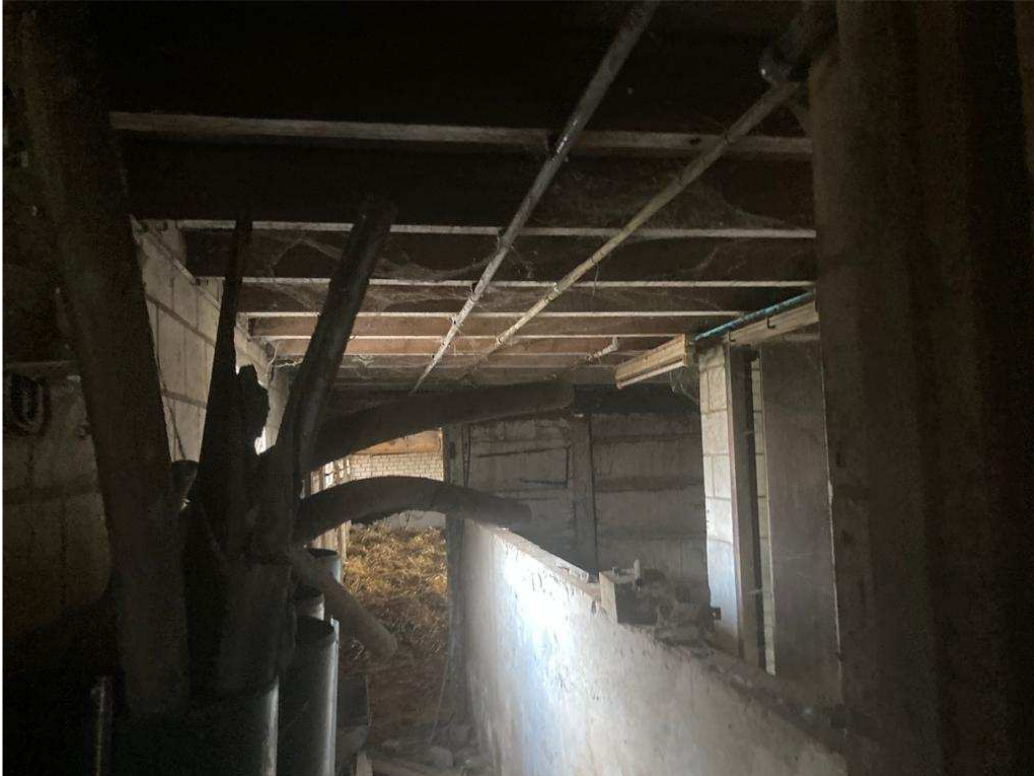
• Afbeelding 9: ongeïsoleerde tussenbouw
