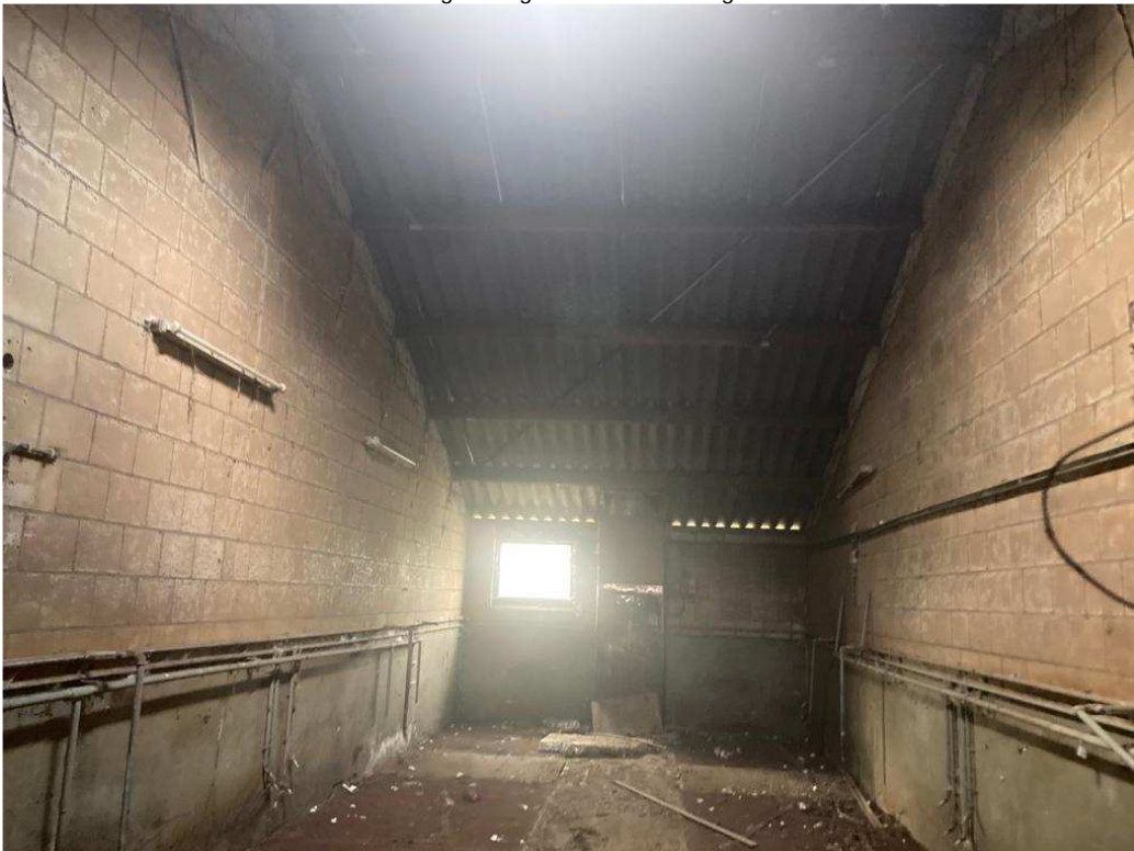
• Afbeelding 10: ongeïsoleerde voormalige varkensstal
