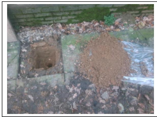
Foto 4. Opgegraven en gezeefd materiaal asbestinspectiegat 04
