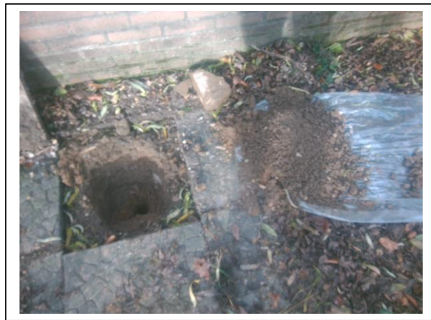
Foto 2. Opgegraven en gezeefd materiaal asbestinspectiegat 02
