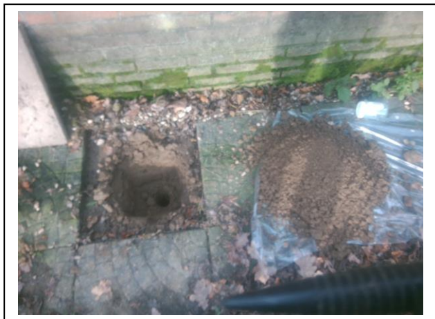
Foto 3. Opgegraven en gezeefd materiaal asbestinspectiegat 03
