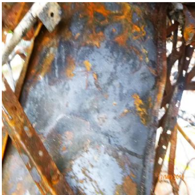
Geïnspecteerde stalen delen
