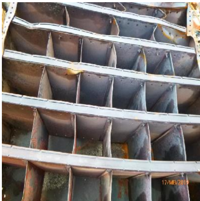
Geïnspecteerde stalen delen
