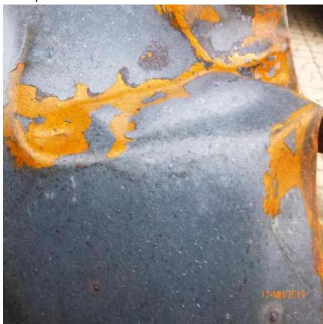
Geïnspecteerde stalen delen
