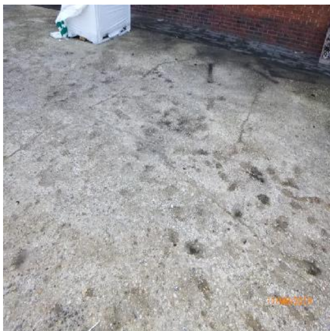
Geïnspecteerde betonplaat naast de brandhaard
