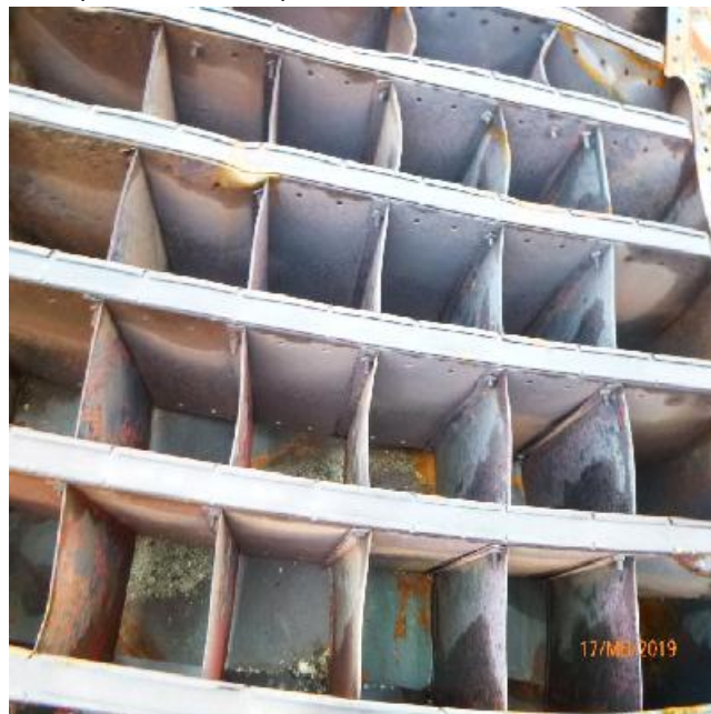
Geïnspecteerde stalen delen
