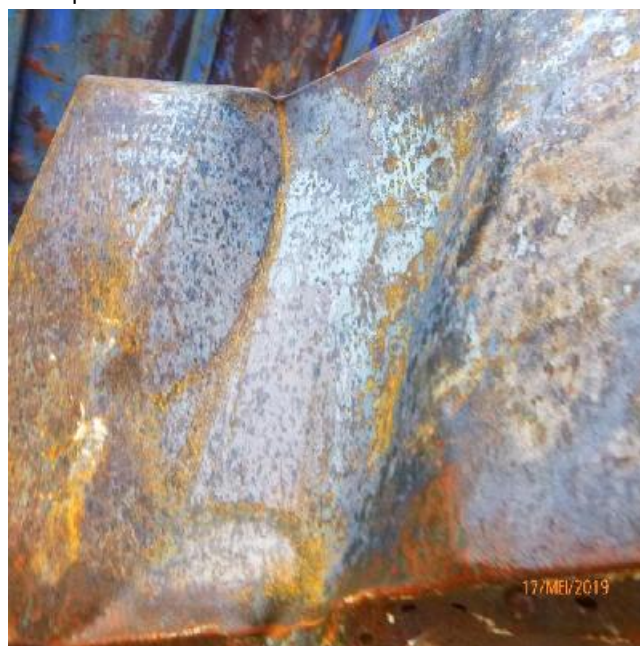
Geïnspecteerde stalen delen
