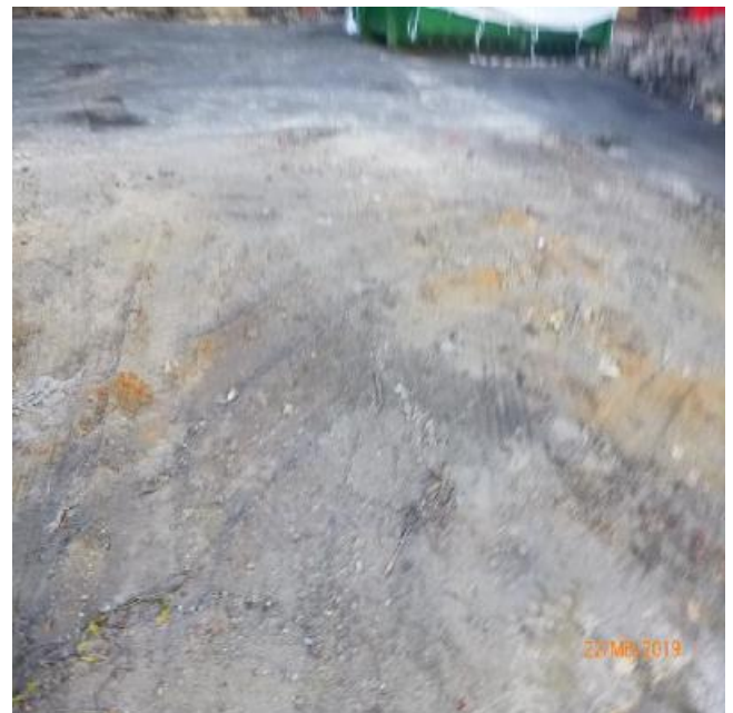
Overzicht foto compleet verwijderde gesloopten bouwdelen van de brandhaard (opslagloods en werkplaats)
