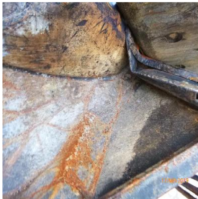
Geïnspecteerde stalen delen
