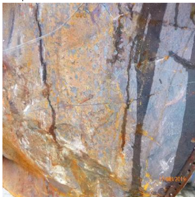
Geïnspecteerde stalen delen
