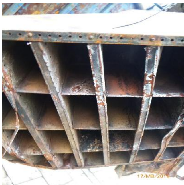
Geïnspecteerde stalen delen
