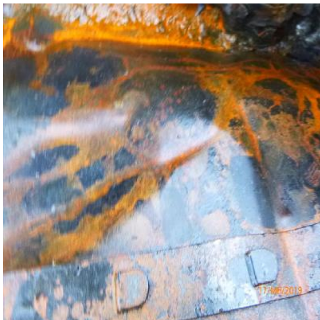
Geïnspecteerde stalen delen
