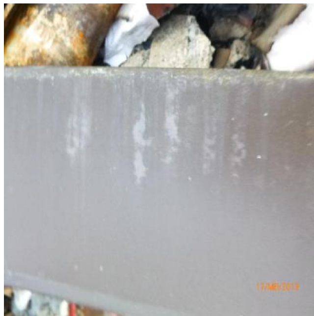
Geïnspecteerde stalen delen
