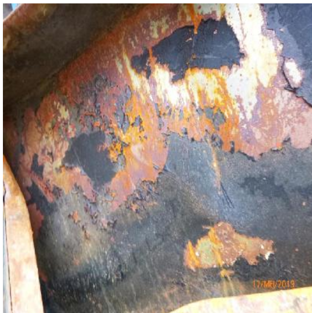
Geïnspecteerde stalen delen
