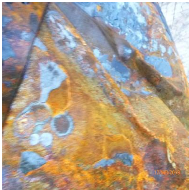
Geïnspecteerde stalen delen
