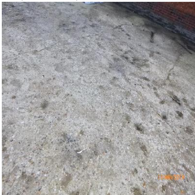
Geïnspecteerde betonplaat naast de brandhaard
