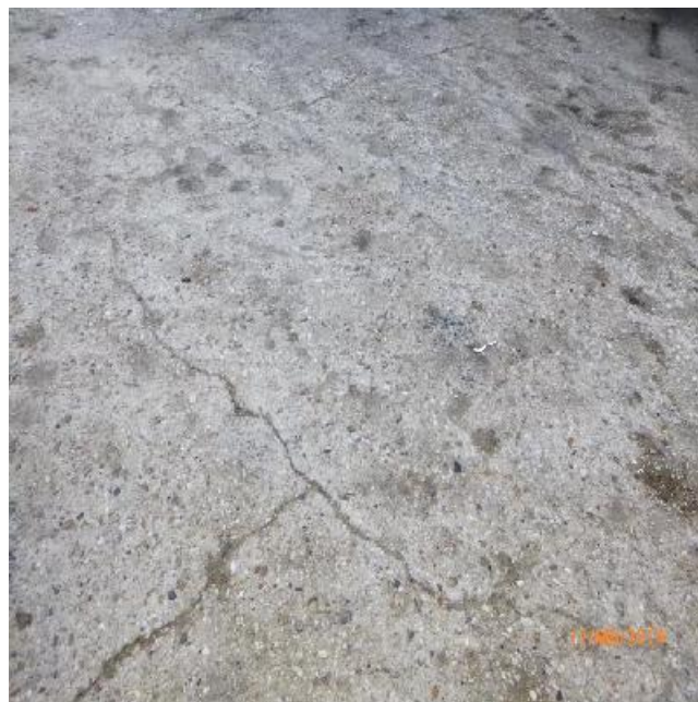
Geïnspecteerde betonplaat naast de brandhaard
