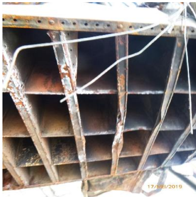
Geïnspecteerde stalen delen
