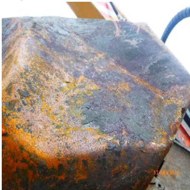
Geïnspecteerde stalen delen
