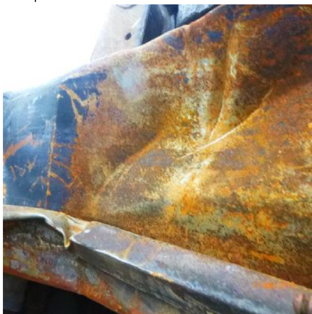
Geïnspecteerde stalen delen
