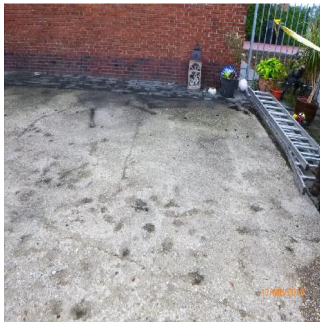
Geïnspecteerde betonplaat naast de brandhaard
