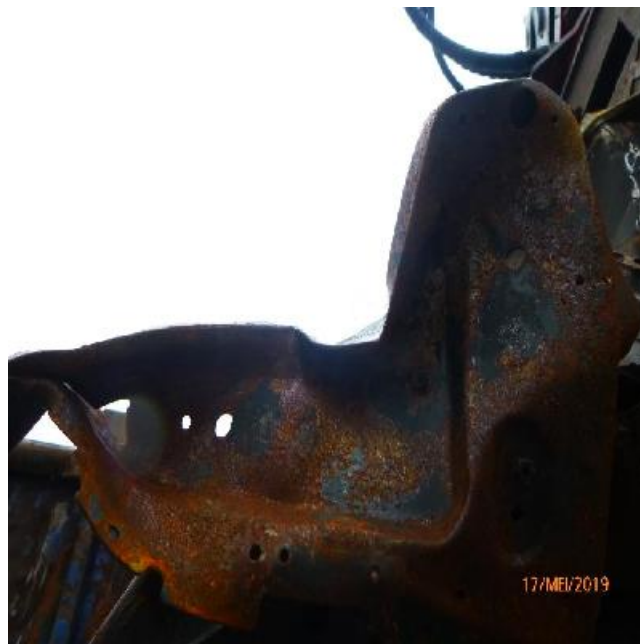
Geïnspecteerde stalen delen
