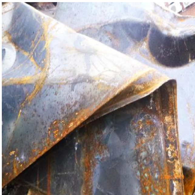
Geïnspecteerde stalen delen
