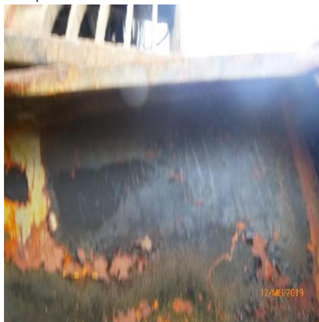
Geïnspecteerde stalen delen
