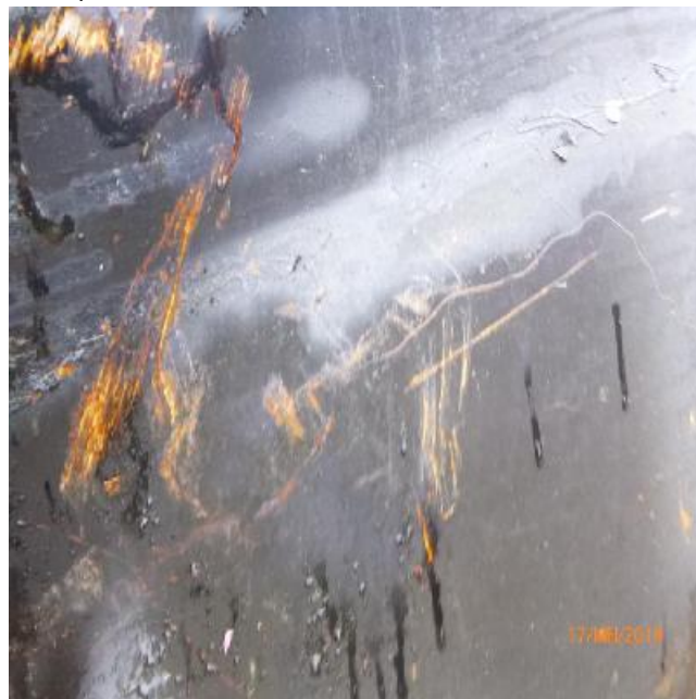
Geïnspecteerde stalen delen
