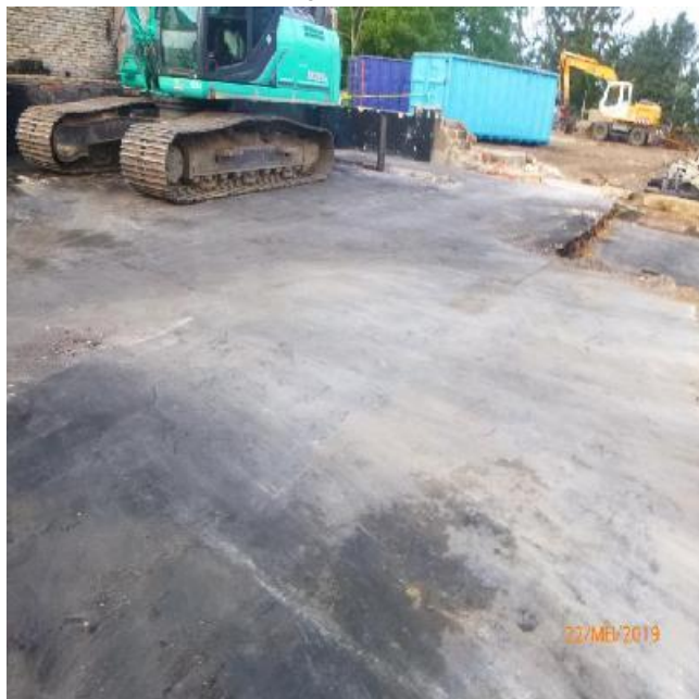
Overzicht foto compleet verwijderde gesloopten bouwdelen van de brandhaard (opslagloods en werkplaats)
