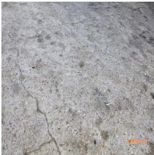
Geïnspecteerde betonplaat naast de brandhaard
