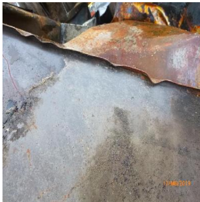
Geïnspecteerde stalen delen
