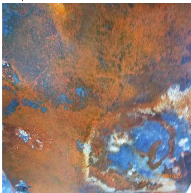
Geïnspecteerde stalen delen
