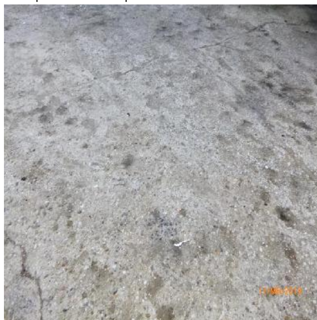
Geïnspecteerde betonplaat naast de brandhaard
