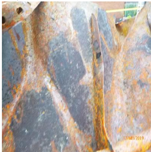
Geïnspecteerde stalen delen
