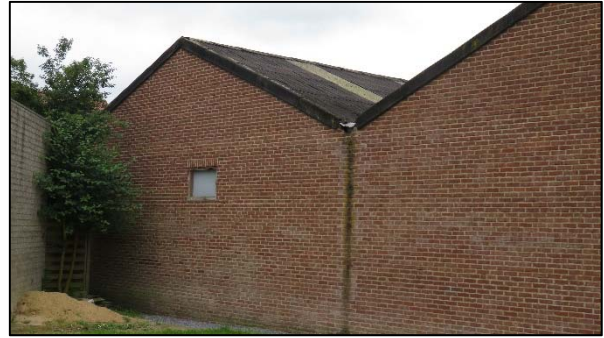
Foto 2. Te slopen gebouwen
