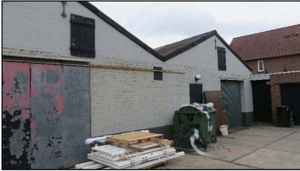
Foto 1. Te slopen gebouwen
