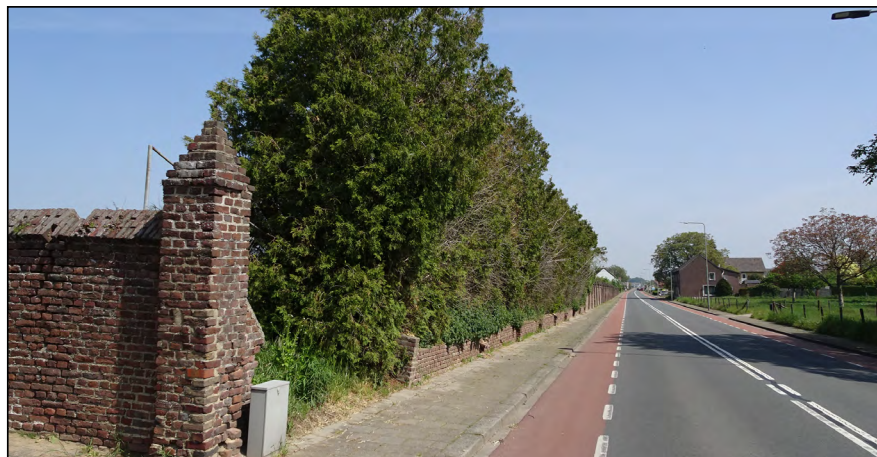
Figuur: Een groot deel van het gebouw en de kloostertuin zijn ommuurd en deels in verval. In de begroeiing kunnen vogelnesten aanwezig zijn. Op de kloostermuren kunnen beschermde planten aanwezig zijn.
