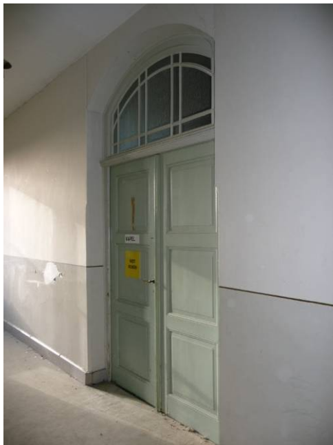
63 deur met bovenlicht tussen gang 1.21 en 1.17
