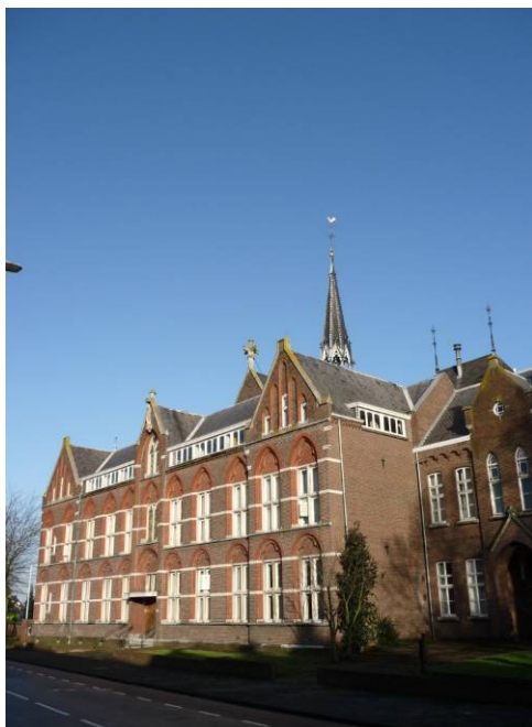
26 de voorgevel van de zuidvleugel
