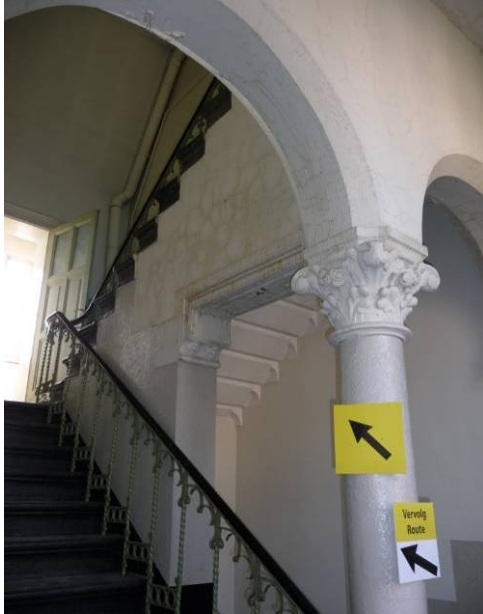
74 het trappenhuis in ruimte 31
