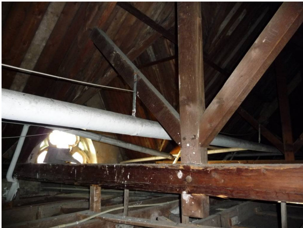
52 één van de ‘verbeterde Hollands spanten’ van de kapconstructie van de zuidvleugel
