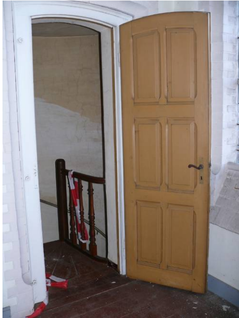
99 toegang tot wenteltrap op de 2e verdieping
