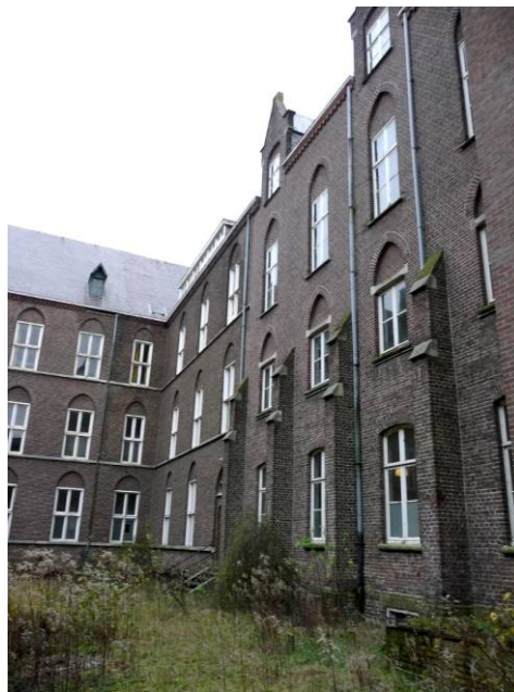
36 westelijke gevel van de oostvleugel (noord)
