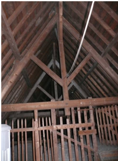
101 kapconstructie boven de kapel
