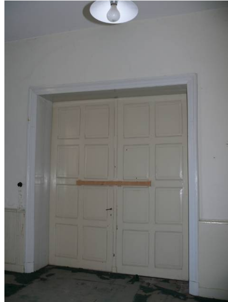
62 dubbele paneeldeur tussen ruimte 27 en 28
