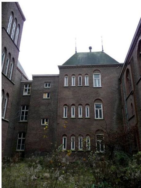
31 de achtergevel van de zuidoostvleugel
