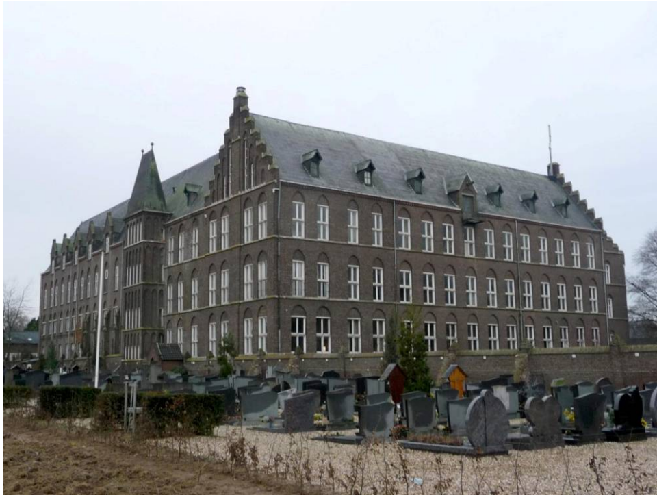
37 de noordelijke gevel van de noordvleugel (Mariavleugel)
