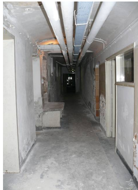
60 gang 0.12 richting het zuiden
