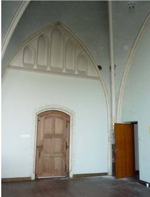
95 oostelijke zijmuur van de tribune
