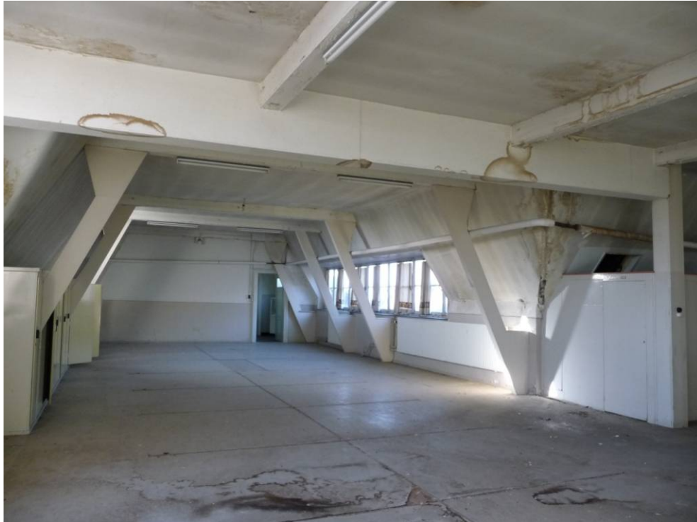
85 kapruimte 3.15 richting het zuiden
