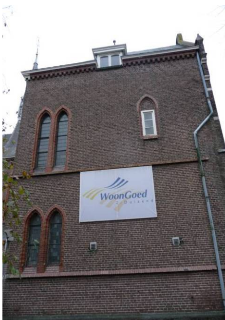
28 westelijke zijgevel zuidvleugel
