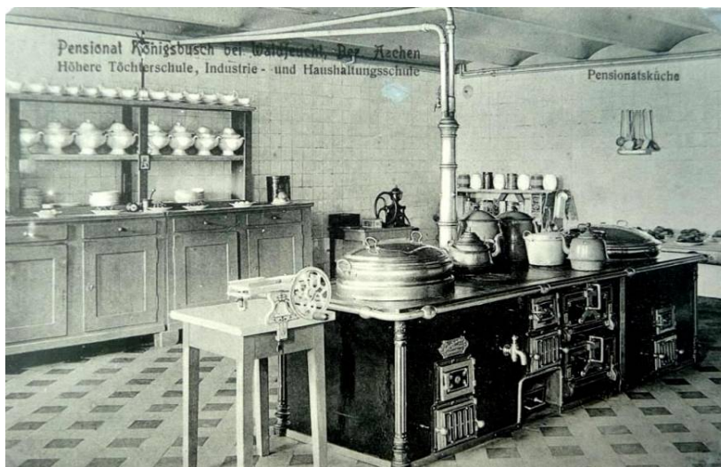
10 de pensionaatskeuken in het souterrain in de vroege twintigste eeuw
