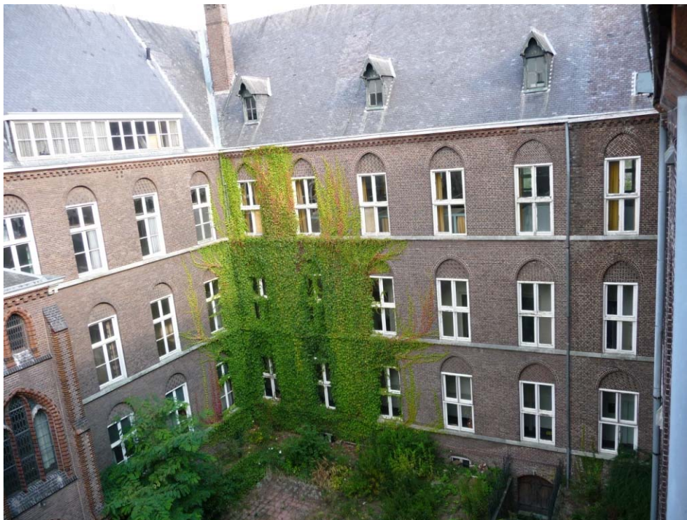
40 de noordvleugel aan de binnenplaatszijde
