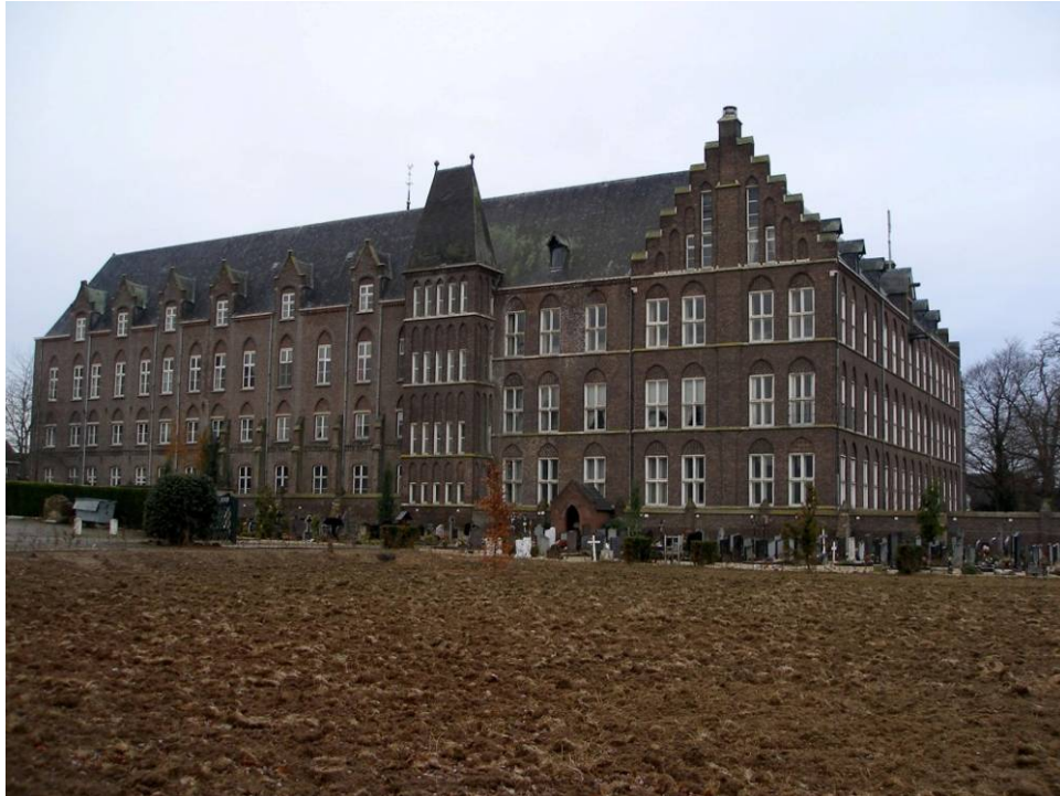
33 de oostelijke zijgevel van de oostvleugel
