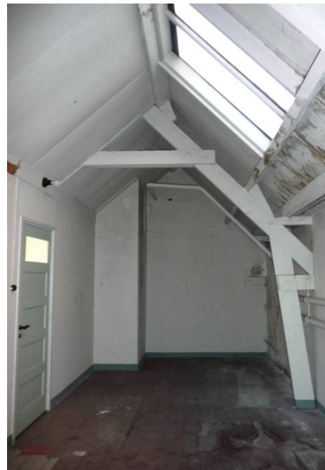
51 grenen kapsant van de dakconstructie
