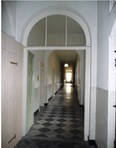
61 gang 23 richting het zuiden
