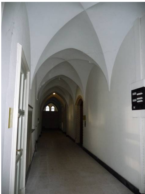
46 gang 4 in de zuidvleugel richting westen
