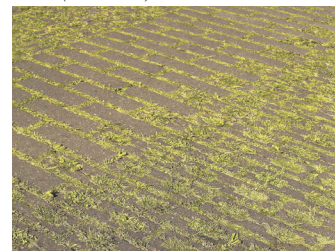
voorbeeld van karrenspoor als rijbaan (foto boven) materialisatie karrenspoor van 4 meter breed (foto onder)
