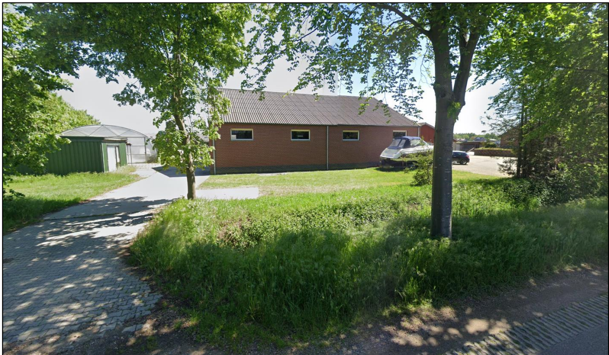
Figuur 13 - Zijkant hoge stal Dominicusweg 2 (Google Streetview)
