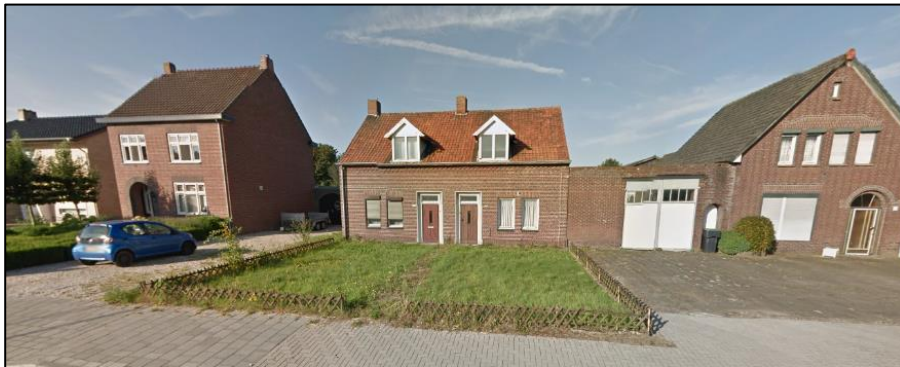
Foto bestaande situatie
