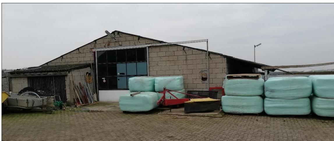
Afbeelding staat van de te slopen opstallen
