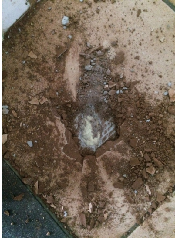
6. M.03 Vloerzeil onder tegelvloer
