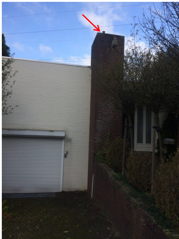
1. M.01 buismateriaal in schoorsteenkanaal
