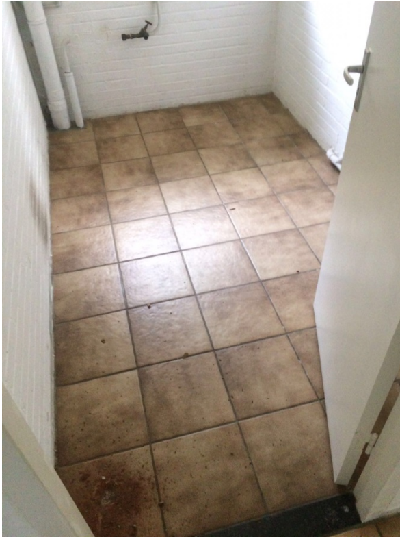
5. M.03 Vloerzeil onder tegelvloer
