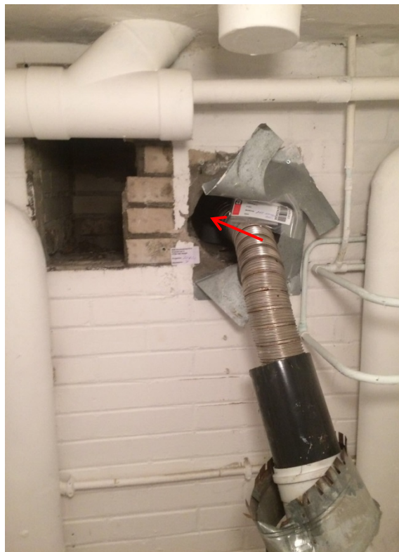
2. Als M.01 aanzicht kelder op asbestbuis in schoorsteenkanaal
