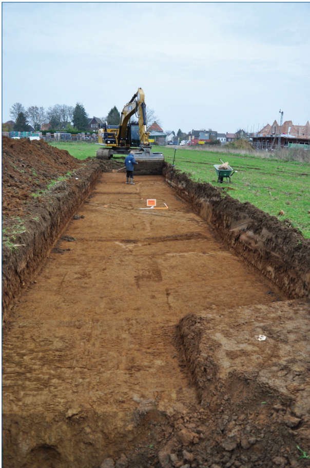
Figuur 5. Aanleg van een proefsleuf (put 22).
