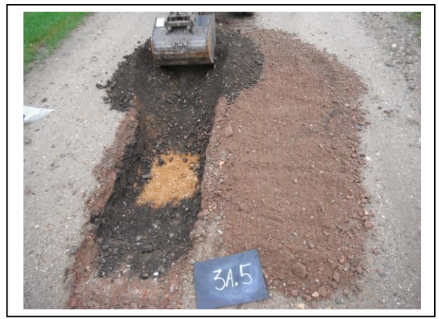
Foto 48. Asbestinspectiegat gat 3a.5
