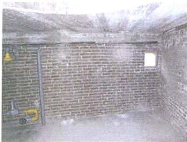
foto 15 verwijderde ventilatie buizen berging 1° verdieping
