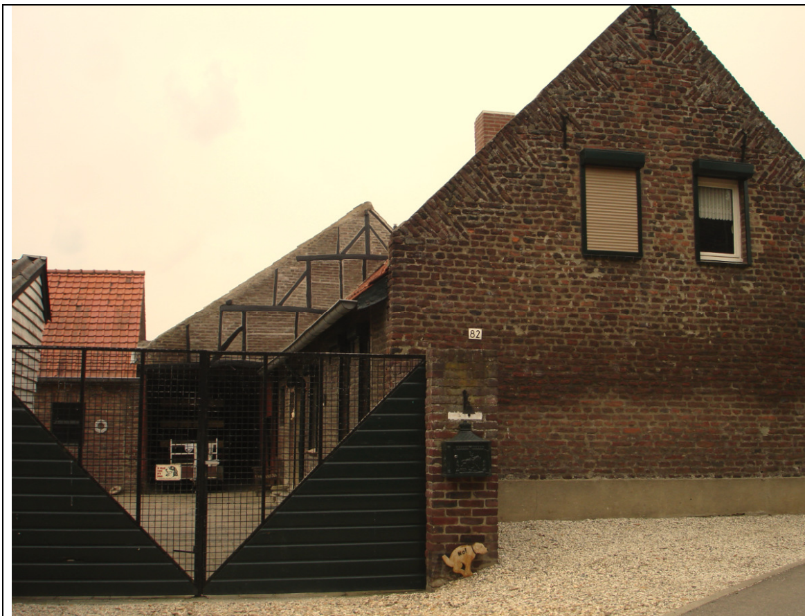
Resten van vakwerkbouw in historische bebouwing te Aasterberg (foto: Luuk Keunen, 6 mei 2014).
