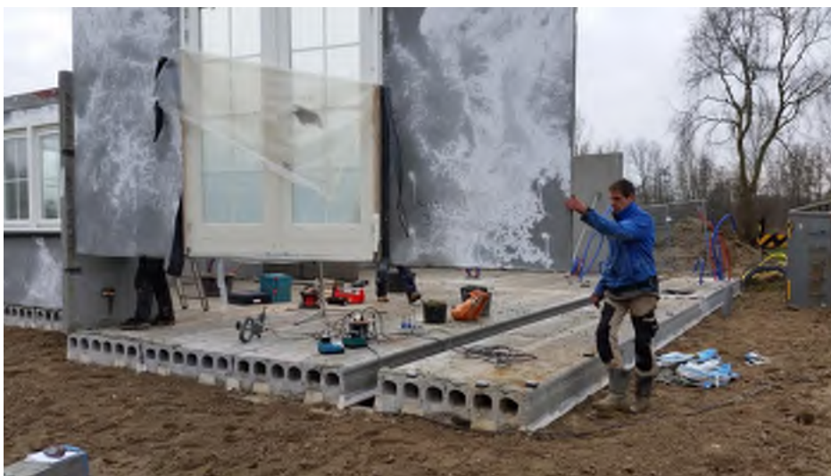
Figuur 3: Fundering nieuwbouwwoningen. Op de foto zijn de betonnen platen te zien waarop de woningen worden geplaatst. Tussen de meest rechtse betonnen plaat en de drie links daarvan, is nog net één van de funderingsbalken te zien.
