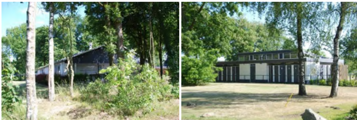
Figuur 27: Te slopen gebouwen
