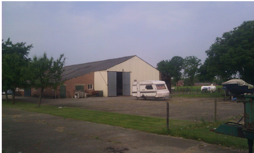
Achterzijde schuur (voormalige stal)
