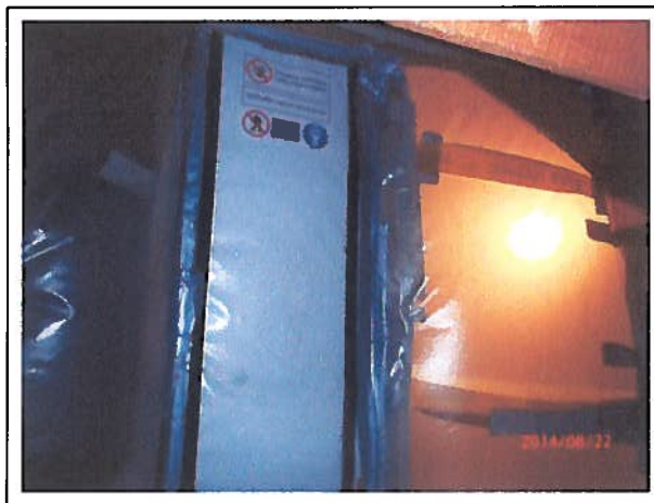
Foto 8: Ingang vuile ruimte vanuit het containment
