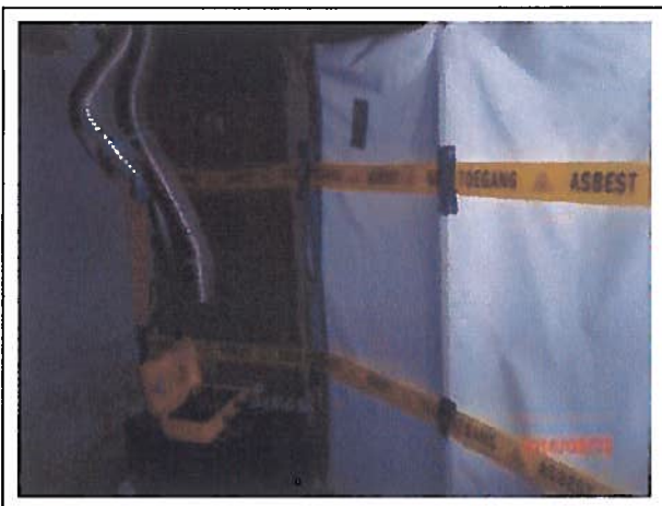
Foto 3: Containment opgebouwd uit folie en tape
