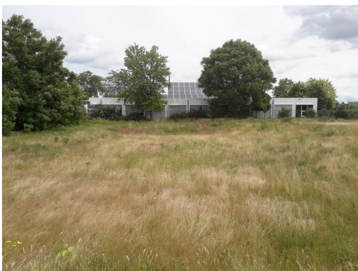
Foto 15: Braakliggend terrein richting Mussenstraat (de ontgravingsput van de sloop is duidelijk zichtbaar)
