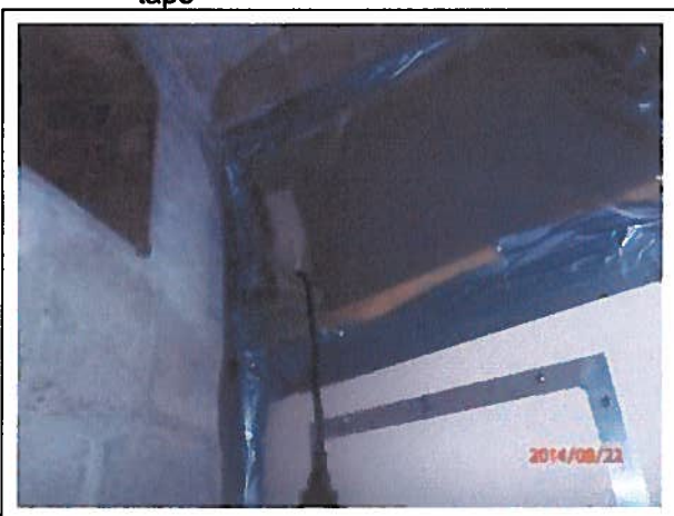
Foto 5: Containment opgebouwd uit folie en tape
