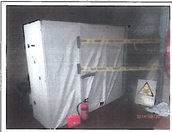
Foto 3: Sluis in de gymzaal
