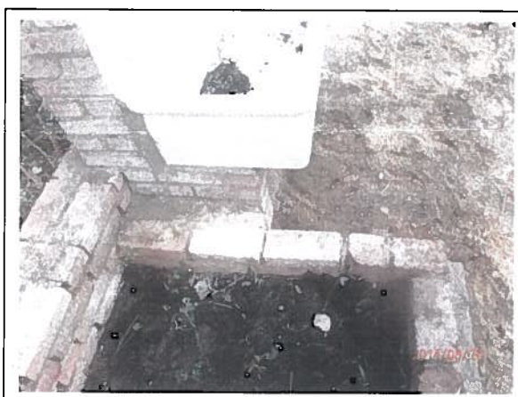
Foto 4: Verwijderd restanten plaatmateriaal
