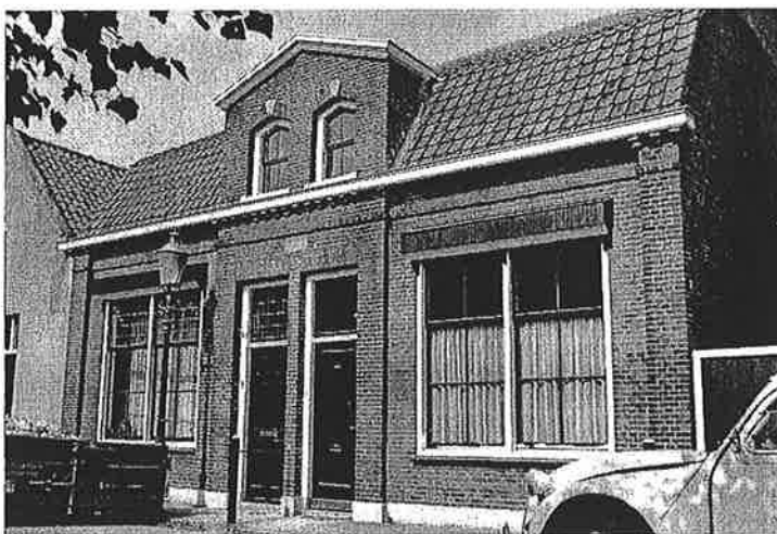
* 15-17 Dubbel eenlaags woonhuis (1882). Mansardedak. Symmetrische voorgevel met hoekpilasters en middenrisaliet waarboven topgevel.
