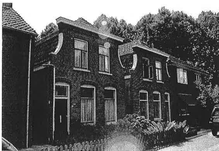
* 19-21 Twee ten opzichte van elkaar vrijstaande eenlaags huizen (1915). Twee parallelle zadeldaken met wolfeind. Ingezwonke lijstgevels aan de straat. Muuropeningen op begane grond met segmentboog, op de verdieping met hanekam. T-vensters. Voor huis nr. 19 erfafscheiding met ligusterhaag.
