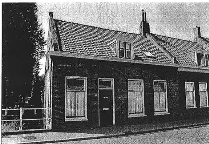
* 46 Eenlaags woonhuis (ca. 1900). Zadeldak tussen tuitgevels. Voorgevel vier traveeën breed. Onder goot muizentand. Muuropeningen met segmentboog en T-vensters. Dakkapel met kleine tympaan en wangen.
