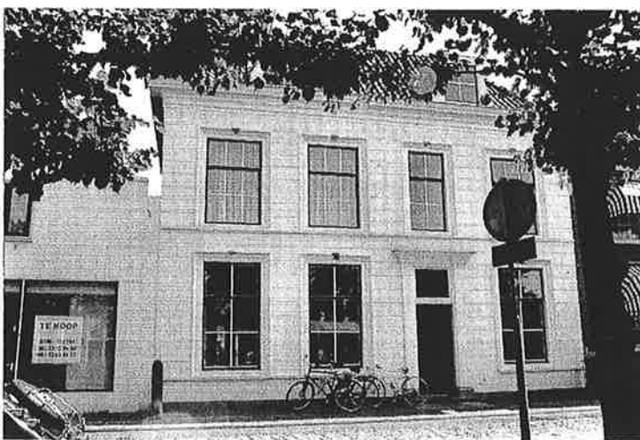
* 63 Tweelaags herenhuis van vier traveeën in Empire stijl (begin 19 e eeuw). Schilddak. Dakkapellen met voluten. Monumentale ingangspartij met pilasters en kroonlijst. Met als latere versiering het gebosseerde pleisterwerk en kuiven in stuc (derde kwart 19 e eeuw). Twee hardstenen stoeppalen met hekwerkje naar de gevel. Rijksmonument
