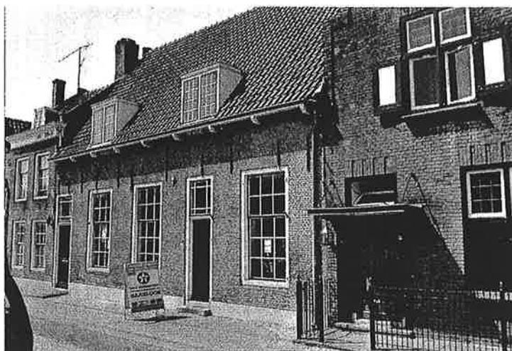
* 24 Voormalig N.H. weeshuis (ca. 1795). Eenlaags pand onder zadeldak. Gevels in gele baksteen. Ramen met zware kozijnen en kleine roedeverdeling. Rijksmonument
