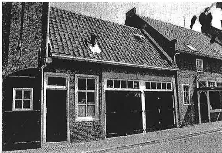
* 1 Eenlaags bedrijfshuis (19 e eeuw, dubbele garagedeuren ca. 1970). Zadeldak. Naast voordeurkozijn één zesruits schuifvenster.
