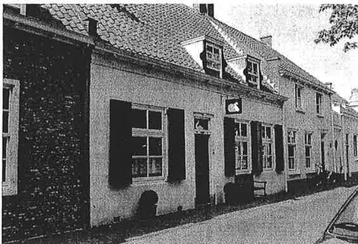
* 42 Eenlaags woonhuis "De Zwaan" (19 e eeuw, mogelijk oudere kern). Zadeldak met tuitgevels. Gebosseerde voorgevel, vier traveeën breed met kroonlijst en fries. Vensters met luiken. Twee dakkapellen met wangstukken Rijksmonument
