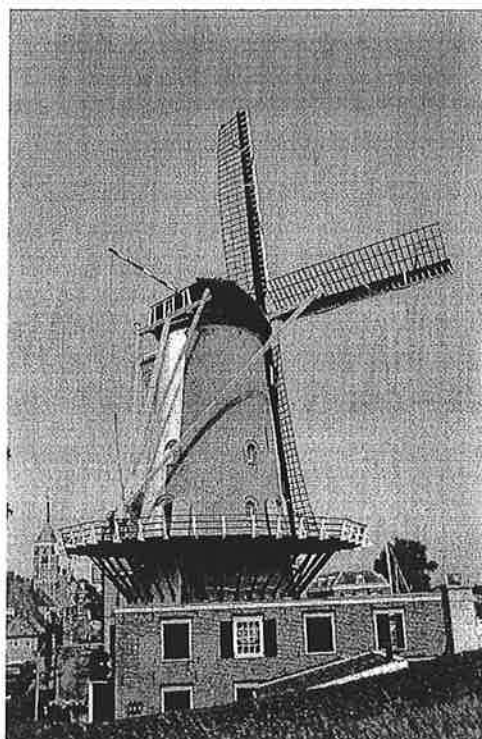
* 11 Ronde stenen stellingkorenmolens "d Orangemolen" (1734), met aangebouwd tweelaags magazijn. Sinds de renovatie van 1967 is het inwendig van de molen dusdanig gewijzigd tot woonmolen, hierbij werd het draaiwerk verwijderd. Rijksmonument
