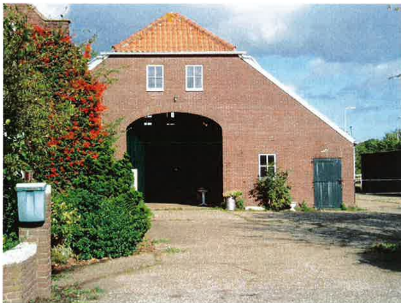
Voormalig agrarisch bedrijfsgebouw, thans een niet agrarische functie
